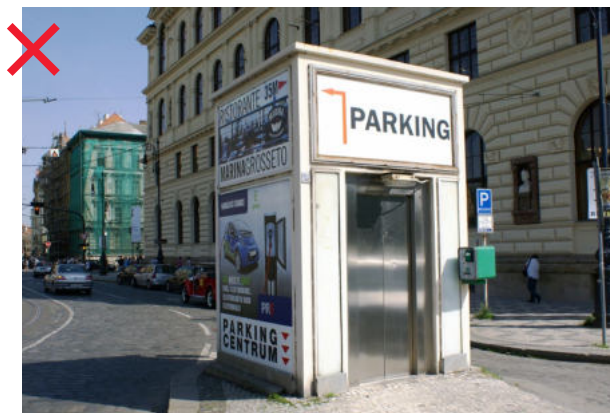
566 Příklad vyústění výtahu, které mimo jiné díky celoplošnému polepu reklamou dominuje svému okolí a omezuje významné pohledové osy [ Praha 1, náměstí Jana Palacha ]
