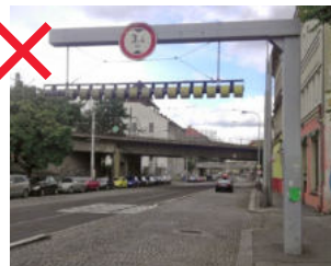
388 Neadekvátní podoba ochrany před srhnutím trolejí pro městský prostor. Lze řešit např. zavěšením subtilnějších signálních prvků na převés trolejového vedení či jiným, městským způsobem [ Praha 5, Nádražní ]
