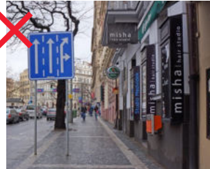
385 Značky se dvěma sloupky omezující průchodnost chodníku. Značka by mohla být minimalizované velikosti a ideálně osazena na nejbližší sloup veřejného osvětlení [ Praha 2, náměstí Míru ]
