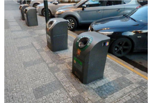
443 Kvalitní podzemní kontejner s průběžnou dlažbou [ Praha 1, Platněšská ]
