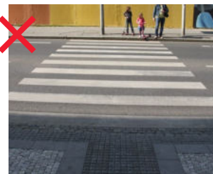
112 Bezbariérová úprava přechodu provedená jen z jedné strany naprosto pozbývá funkčnosti [ Praha 7, Letná ]
