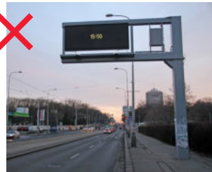
386 Nevhodné použití návěstidel dálničního typu v městském prostředí. Takové prvky by se ve městě neměly vůbec vyskytovat. Svou mohutností zabraňují průhledům ulic, zaclání fasády domů a často zabraňují průchodu v pěším prostoru [ Praha 3, Jana Želivského ]
