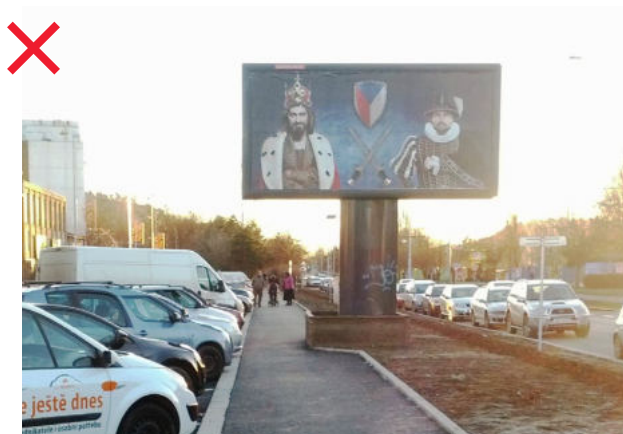
576 Samostatně stojící stavba pro reklamu, která vedle toho, že má příliš velké rozměry, omezuje pohyb ve veřejném prostoru [ Praha 4, Podolí ]
