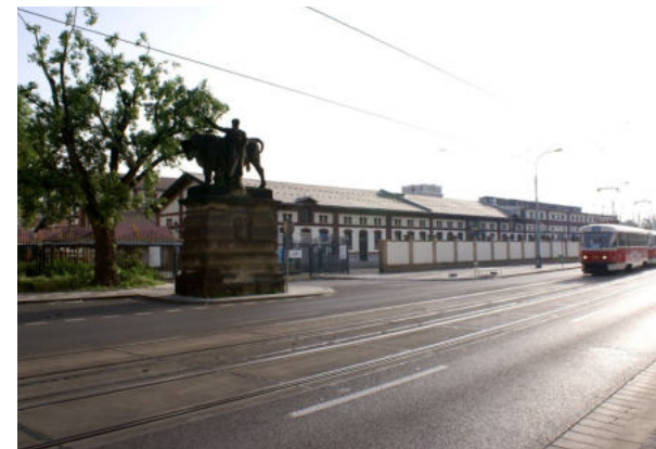
053 Zeď areálu může mít opodstatnění, pokud není pouhou izolující bariérou, ale kompoziční součástí celku, zdůrazňuje význam místa a odkazuje na jeho historii [ Praha 7, Holešovice, Pražská tržnice ]
