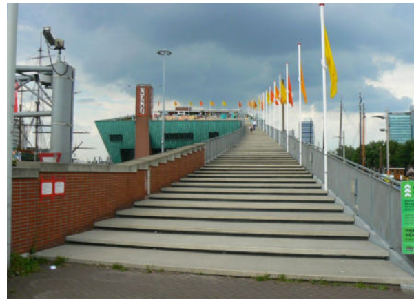
038 Pobytová střecha muzea je veřejně a snadno přístupná přímo z nábřeží. Renzo Piano (1997) [ Nizozemí, Amsterdam, Science Center Nemo museum ]
