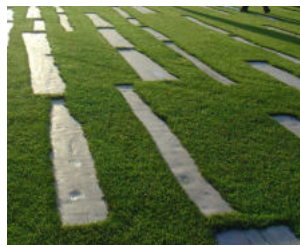
288 Velkoformátové desky pro pohyb po nepevněném povrchu Použití: parky, trávníky, zpravidla mimo historické město
