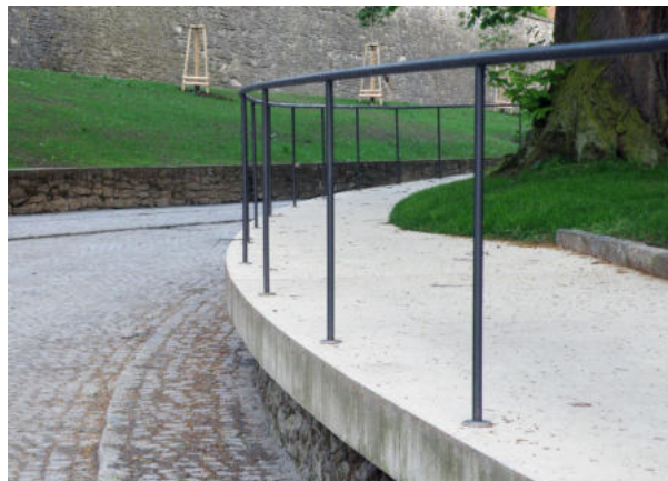
488 Vhodný příklad subtilního zábradlí jednotné barevnosti a umírněného designu [ Litomyšl, Jiráskova ]
