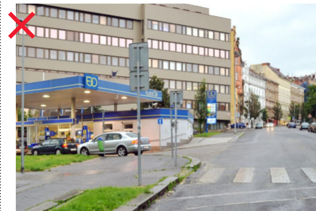
559 Silniční čerpací stanice nevhodně umístěná jako solitér v prostředí kompaktního města generuje zbytečné neudržovatelné plochy [ Praha 3, U Rajske zahrady ]
