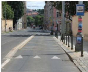
119 Vídeňská zastávka s jasně čitelným a odlišitelným charakterem vozovky a chodníku [ Praha 2, Albertov ]
