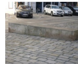
202 Vhodná materiálová kombinace povrchů a prvků z různých barevně sladěných materiálů [ Brno ]
