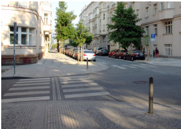
105 Křižovatka zklidněných ulic s vysazenými chodníky sníženými do úrovně vozovky a přechody na všech ramenech křižovatky [ Praha 6, Eliášova ]
