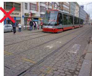
236 Různě vzdálené zakončení různorodého povrchu v rámci křižovatky je z celkového vnímání prostoru nevhodné. Křižovatka by měla mít celkově jednotný povrch s jasným vymezením oproti navazujícímu povrchu ulice [ Praha 2, Karlovo náměstí ]
