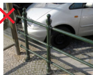
496 Nově vybudované historizující zábradlí mimo historické město není z hlediska tvarosloví vhodné [ Praha 6, Svatovítská ]
