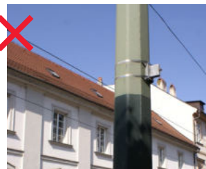
246 Barevnost sloupů a prvků by měla být jednotná pro celý prvek [ Praha 1, Letenská ]
