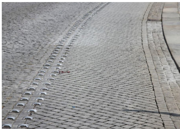
219 Vhodné materiálové řešení cyklistického pruhu z hladší dlažby v místech s hrubou dlažbou v historickém a kompaktním městě [ Německo, Drážďany ]
