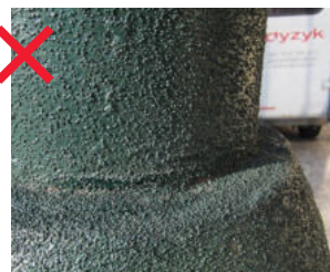
248 Nevhodná povrchová úprava proti plakátům v podobě příliš hrubé zrnitosti [ Praha 1 ]
