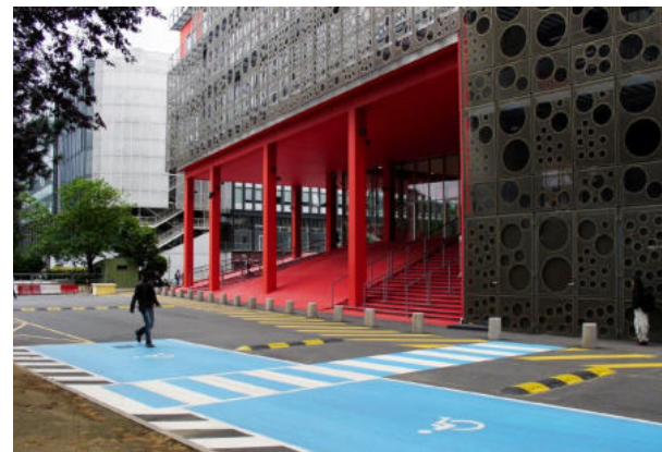
048 Umně ztvárněné provozní uspořádání ulice technicistní grafikou formálně odkazuje na architekturu dominanty. Škola a její předprostor spolu vizuálně korespondují. Périphériques Architectes (2004) [ Francie, Paříž, Jussieu 16M / L'Atrium ]
