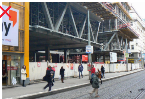
526 Kulturnost ohrazení stavby neodpovídá dlouhodobému dopravnímu a prostorovému omezení ve stanici Národní třída. Stavba by měla mít městotvorný charakter již při realizaci [ Praha 1, Národní třída ]
