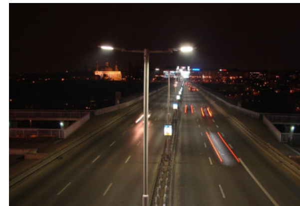
402 Veřejné osvětlení dopravního tahu neutrálně bílým světlem [ Praha 4, Nuselský most ]
