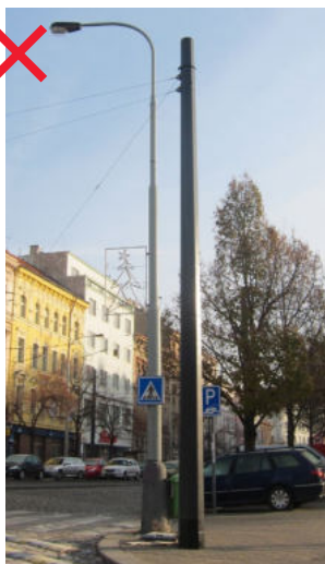
373 Dublování sloupů trakčního tramvajového vedení a veřejného osvětlení je třeba předcházet sdružováním jejich funkcí. Není vhodné zachovávat současný stav, kdy jsou často i při rozsáhlých rekonstrukcích vedle sebe umístovány a ponechávány sloupky trakčního vedení tramvaje a veřejného osvětlení [ Praha 10, Moskevská ]
