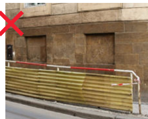
494 Nevhodná výplň zábradlí neadekvátní městskému prostředí, která působí dočasným dojmem a morální dožilostí již v době instalace a zároveň neumožňuje průhled [ Praha 1, Smetanovo nábřeží ]
