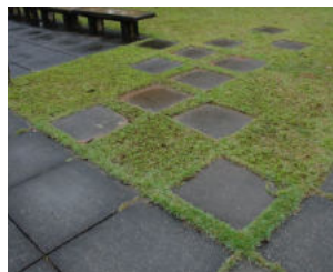
287 Velkoformátové desky pro pohyb po nepevněném povrchu Použití: parky, trávníky zpravidla mimo historické město
