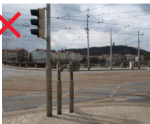
380 Nevhodné dublování sloupků SSZ. Je-li to možné, měly by být ovladače umístěny přímo na stožáru SSZ [ Praha 2, Palackého náměstí ]
