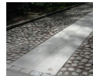
204 Vhodné doplnění pohodlně hladké velkoformátové dlažby do povrchu historické dlažby, která není pro chůzi pohodlná [ Švédsko, Stockholm ]
