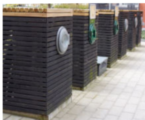
447 Kultivovaná nadzemní část alternativního způsobu nakládání s komunálním odpadem – podtlakového potrubního systému v rámci ucelené obytné lokality [ Stockholm, Hammarby Sjödstadt ]
