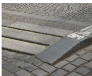
310 Stupňovaný kamenný žulový obrubník Použití: vjezdy do zvýšených křižovatek a vídeňských zastávek
