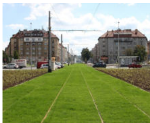
234 Tramvajový pás po zatravnění. Tento druh zatravnění vyžaduje vysoké nároky na údržbu v podobě zavlažování a sečení [ Praha 6, Podbaba ]
