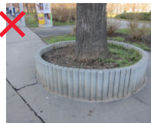
323 Příklad neakceptovatelné změny úrovně terénu, při které přišel strom o většinu kořenového systému [ Praha ]
