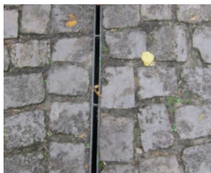
354 Liniové štěrbinové odvodnění je nenápadné a estetické, ale bývá problematické z hlediska údržby [ Německo, Berlín ]
