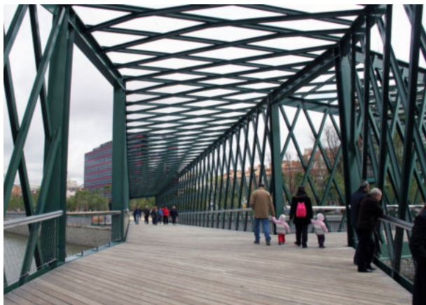
560 Architektonicky kvalitní lávka a současně městská promenáda s pobytovým charakterem a akcentací míst výhledů [ Španělsko, Madrid ]
