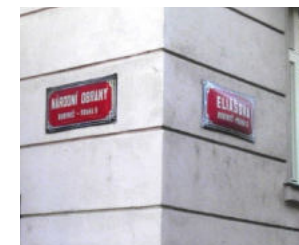
480 Příklad správného zarovnání a odsazení dvou nárožních uličních tabulí [ Praha, Národní obrany ]
