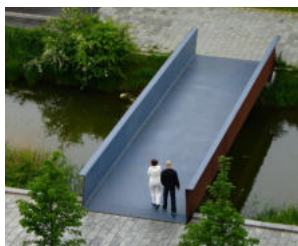
561 Snadno udržovatelná, bezbariérová lávka bez nadbytečných a komplikovaných konstrukčních prvků je rovněž artefaktem, který kultivuje přilehlá veřejná prostранství [ Dánsko, Kodaň ]
