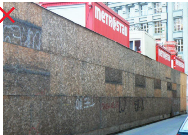
525 Ohrazení stavby z OSB desek, které rychle vizuálně degradují a výrazně tak snižují kvalitu veřejného prostranství [ Praha 1, Národní třída ]
