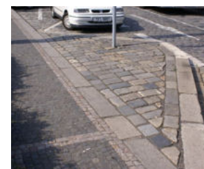
104 Rozšíření chodníkové plochy u parkovacího zálivu při zachování přímé obruby a s materiálovým odlišením přidané části [ Praha 1, Klárov ]
