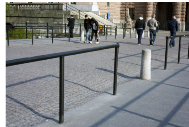
492 Vhodný příklad zábradlí jednotné barevnosti a umírněného designu, které je dostatečně přerušované pro příčné procházení [ Švédsko, Stockholm ]
