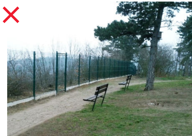
520 Nevhodné užití plotu pro zabránění vstupu na hranu svahu, namísto kvalitního zábradlí [ Praha 4, Branická skála ]
