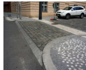
109 Zachovaná kontinuita chodníku a nadřazenost pěšího pohybu v místě napojení zklidněné vedlejší ulice na hlavní ulici [ Praha 10, Moskevská ]
