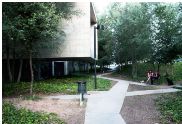
046 Objekt galerie vhodně integrován do městské struktury. Prostranství v bezprostřední návaznosti na budovu je kultivovaným parkem [ Španělsko, Barcelona, Can Framis Museum ]
