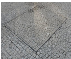
353 Vhodný „neviditelný“ povrch poklopu, který materiálově a výškově navazuje na okolní povrch [ Praha 6, Bubeneč ]
