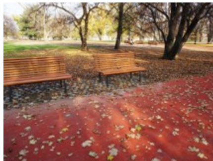
&lt; Probarvený asfalt
