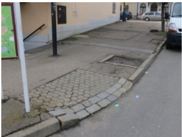
Přechod není plynulý–materiál, formát, barva. Zápłaty v asfaltu. Ponechání rabátka po odstraněném stromu. [ ul. Jiráskova při nádraží ]
