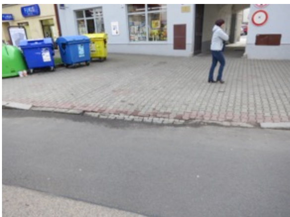
Příklad esteticky i funkčně nevhodného provedení sjezdu na komunikaci. Chybí nakloněný obrubník pro plynulý přechod. [ ul. Tyršova ]
