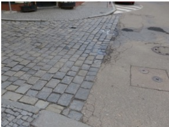
Příklad nesprávného provedení detailu návaznosti materiálů. [ ústí ul. Na Karlově do Masarykova náměstí ]
