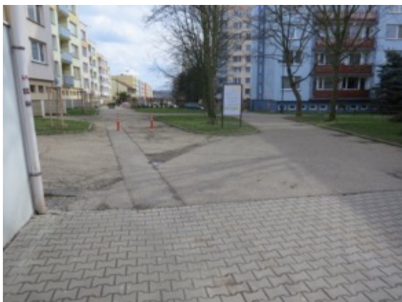
Jen 50m od náměstí. Kombinace nevhodných materiálů v těsné blízkosti centra, nekvalitní provedení, nevhod. provedení oprav. [ pěší propojení z Malého náměstí k ul. Vlašimské ]
