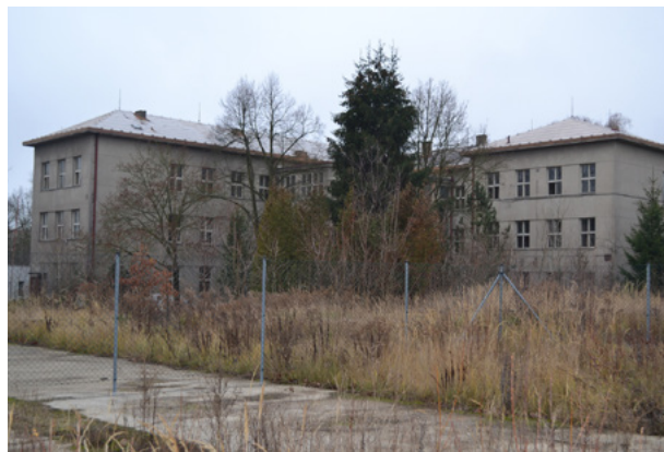
Budovy kasáren před demolicí.
