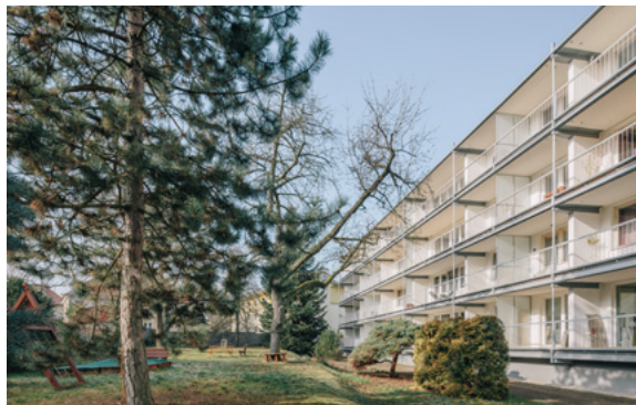
Rozšíření lodžii panelového domu, Praha, re:architekti studio / David Pavlišta, Ondřej Synek, Jan Vlach, Jiří Žid, Vojtěch Ružbatský, 2021
