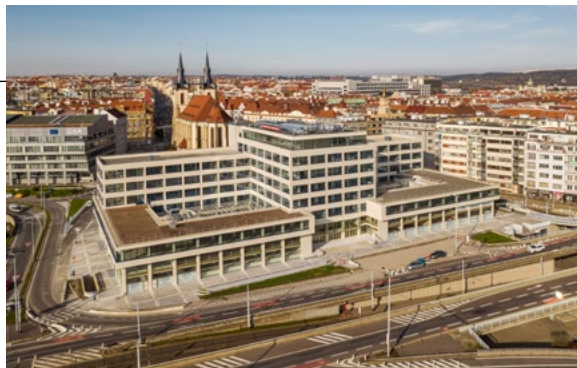
Palác elektrických podniků – rekonstrukce a konverze, Praha / TaK Architects / Marek Tichý
