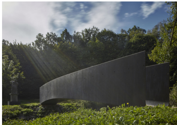
Lávka přes Dřetovický potok, Vrapice u Kladna / Aoc architekti, Ondřej Císler, Petr Tej, KÚ ČVUT. Foto BoysPlayNice
