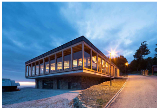
Kamil Mrva Architekt / Výstupní stanice Lanové dráhy na Pustevnách. Foto Studio TOAST
