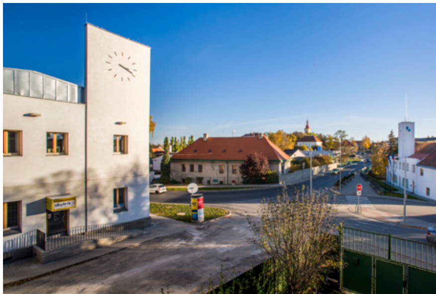
Tři věže, Líbeznice, 2014
