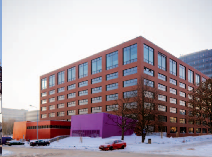
Nová budova ČVUT v Praze Alena Šrámková, Tomáš Koumar, Lukáš Ehl / ŠRÁMKOVÁ
