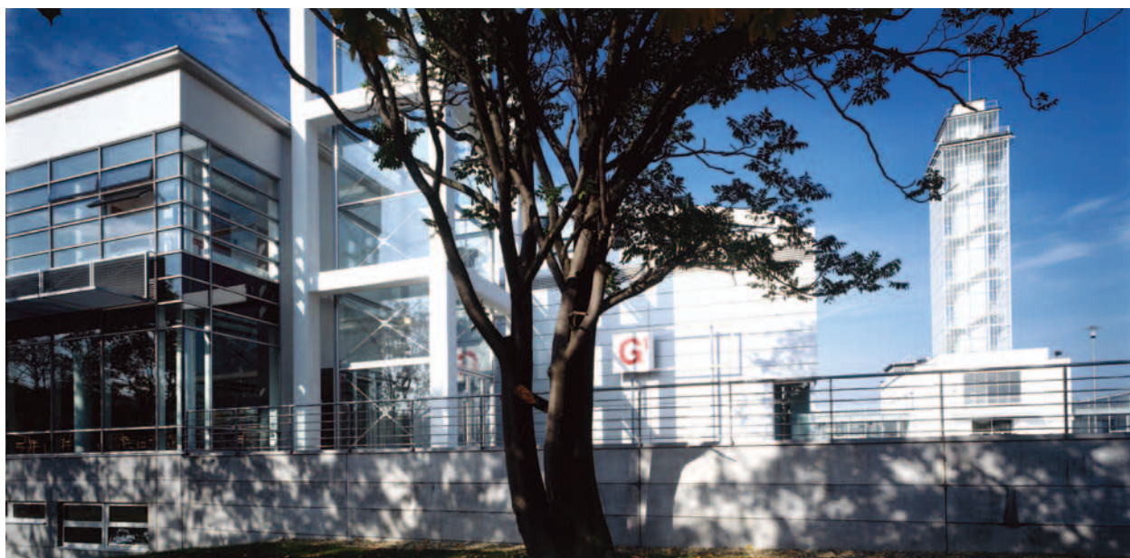
Rekonstrukce a dostavba pavilonu G, BVV (autoři: Viktor Rudiš, Zdeňka Vydrová, Martin Rudiš), 1996, foto archiv Viktora Rudiše
