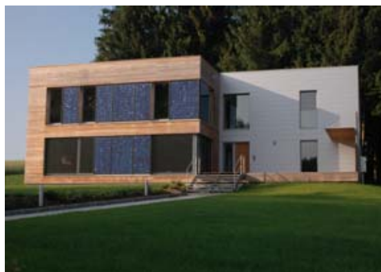
Dům po rekonstrukci. Fasáda s instalovanými fotovoltaickými články
