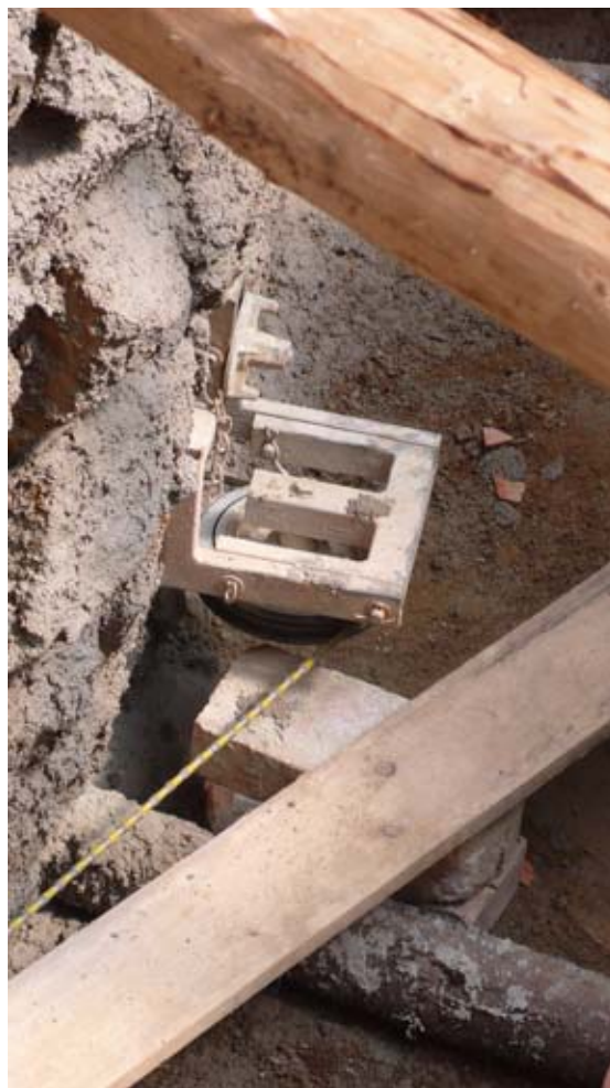
Podřezávání diamantovým lanem, zdroj TRANSAT architekti
