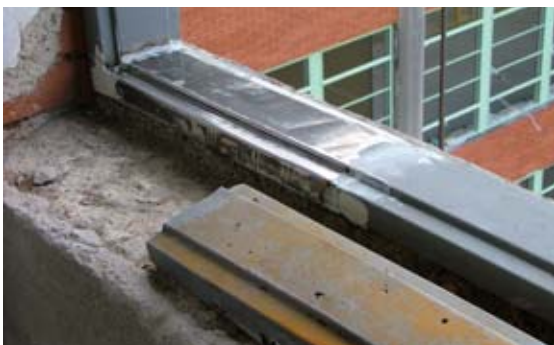
Výměny zkorodovaných částí původních oken
