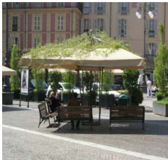
Přístřešky ve veřejném prostoru (Asti, Itálie) – dešťová voda z části tkaniny střechy zavlažuje popínavé rostliny, které jejím průběžným odpařováním, lapáním prachu a ionizováním vzduchu přispívají k fyzické pohodě uživatelů na malém náměstí, kde není prostor pro větší nebezpečné plochy (foto Petr Klápště).
