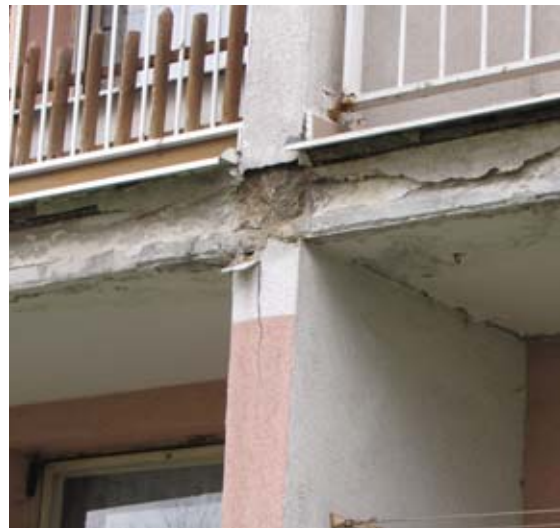
Obr. 5 Pravděpodobně byla použita omítka s vysokým difuzním odporem vodních par a kondenzující vlhkost pod povrchem proces eroze ještě podpořila.
