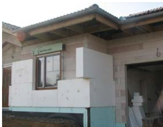
Při montáži na soudržný a rovný povrch lze izolaci celoplošně lepit bez kotvení. Na obrázku 30cm EPS celoplošně lepeno na vápenopískové cihly (foto Kalksandstein).
