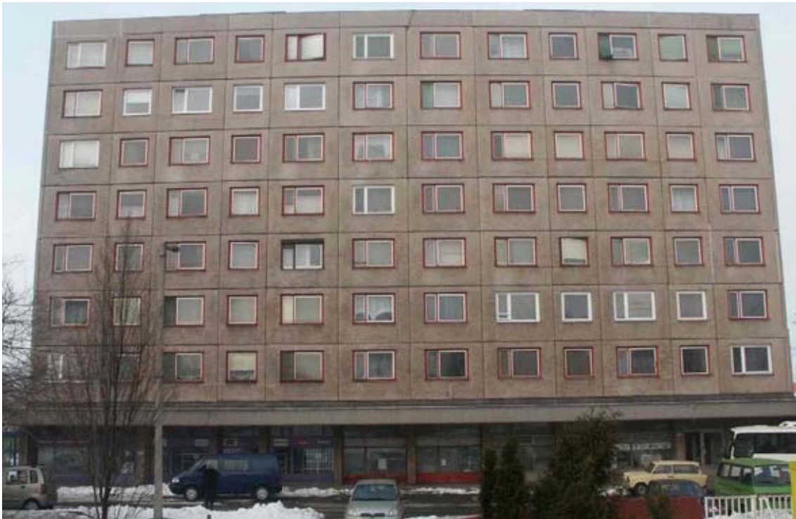
Před rekonstrukcí, rok 2002
