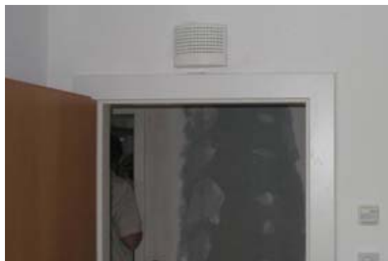
Obr. 18 Viditelné jsou jen výstky nade dveřmi přivádějící vzduch (zdroj CPD).
