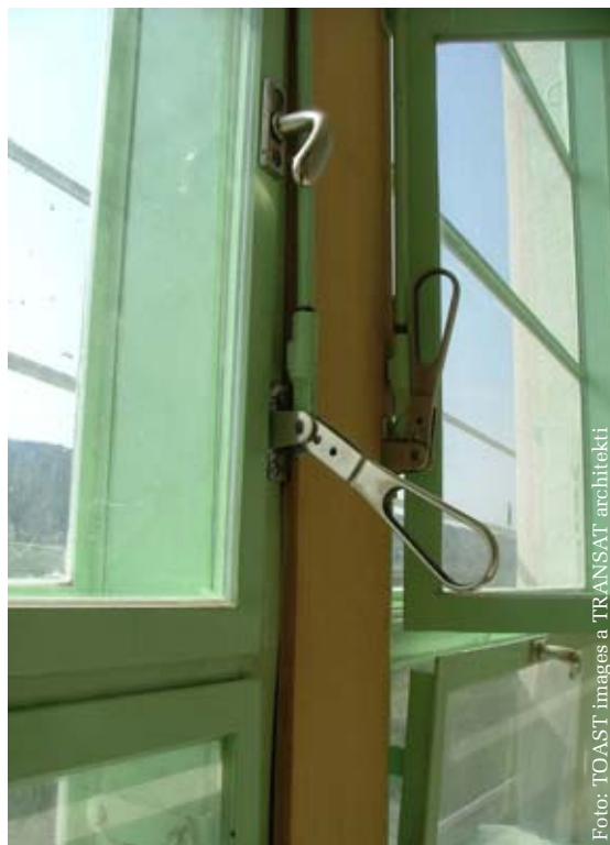
Detail repasovaného původního okna
