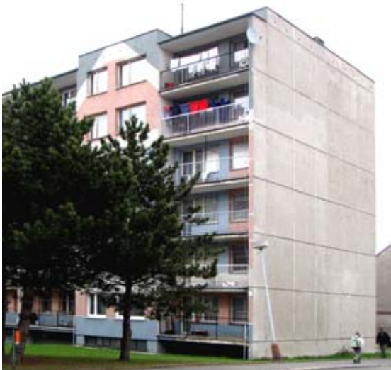
Obr. 1 Běžný šestisekční panelový bytový dům, který před deseti lety prošel povrchní údržbou.
