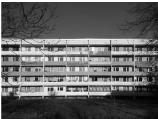
Původní stav panelového domu, na další straně stav po úspěšné konverzi
