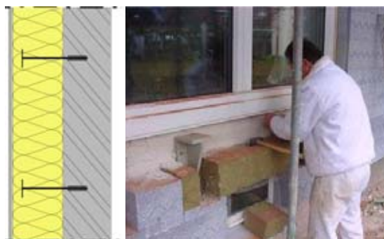
Obr. 5 Nejčastěji se používá kontaktní zateplovací systém s tlustou vrstvou EPS lepený. Pokud je třeba kotvit, tak zásadně zapuštěnou kotevní hmoždinkou ošetřenou zátkou.
