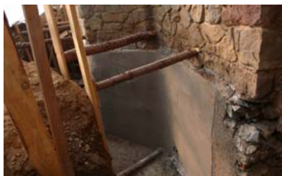
Srovnání líce podřezaného zdiva před aplikací svislé bitumenové stěrkové izolace, zdroj TRANSAT architekti
