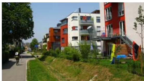
Obytný soubor Vauban (Freiburg, Německo) – svádění a vsakování dešťové vody v uličním prostoru (foto Jan Márton).
