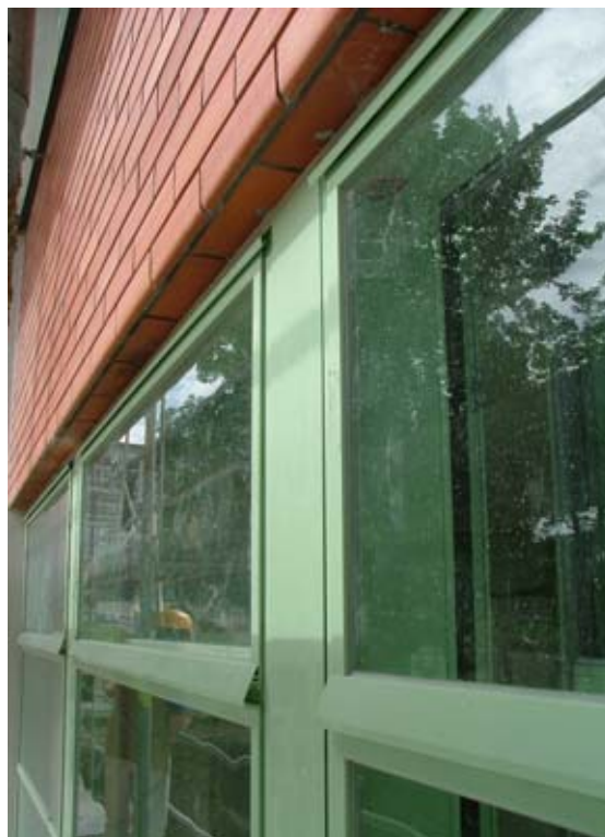
Detail nového okna s opraveným obkladem včetně repliky rohových tvarovek
