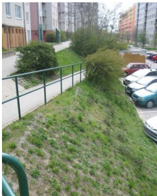
Obr. 11 Původní řešení v témže svahu se skomírajícím trávníkem o kus dále (foto Petr Klápště).
