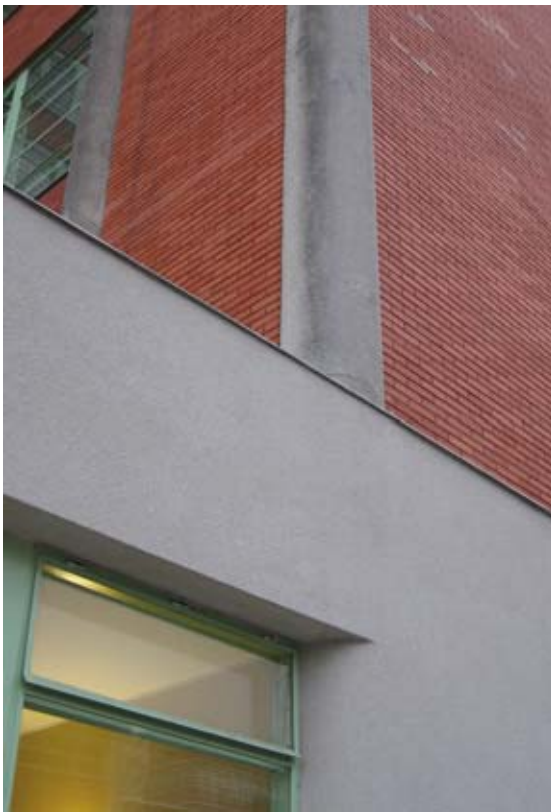
Původní a nové omítky
