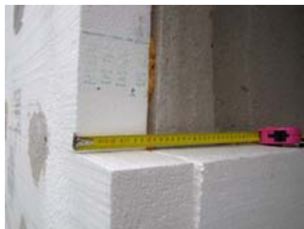
Obr. 6 Zateplení 100mm EPS lepené PUR lepicí pěnou s velkou spárou! Každá mezera nad 2mm by měla být pěnou dotěsněna.
