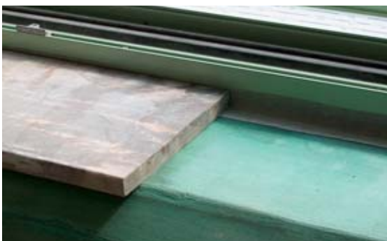
Zpětné osazení mramorové parapetní desky na vnitřní zateplení parapetu nového okna
