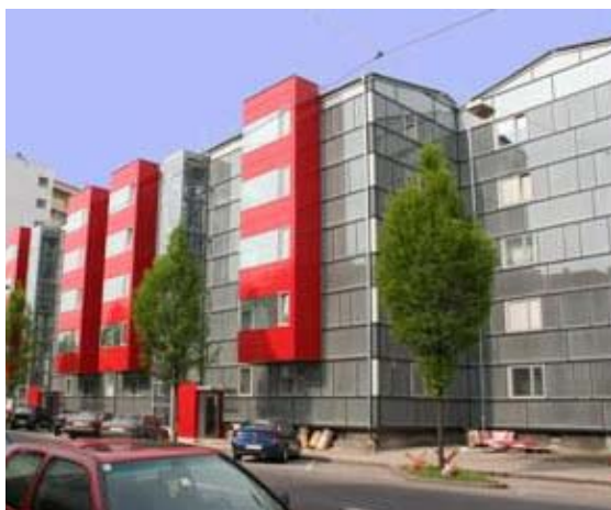
Obr. 61 Architektonicky zajímavě navržená řešení vnějšího vzhledu regenerace panelových domů, Makartstrasse v Linci (foto Petra Blauensteiner).
