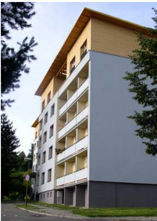
Nástavbou panelového domu lze nejnázne řešit ekonomickou stránku komplexního řešení změny stavby následným prodejem nově vybudovaných bytů. Snímek ze Vsetína (autor: Petr Hovořák, DIMENSE architects).
