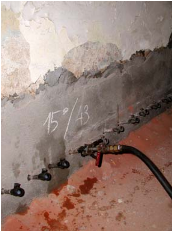
Osazení oburátorů do vrtů při tlakové injektáži
