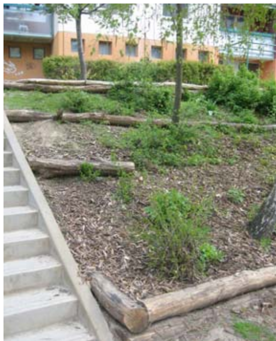
Obr. 10 Nové řešení protierozních opatření a osázení svahu přírodě podstatně bližším způsobem (keře a půdopokryvné dřeviny), Brno-Nový Lískovec. Použité akátové dřevo je vpravdě místní materiál – bylo získáno prořezávkou lesoparku na druhém konci sídliště (foto Petr Klápště).
