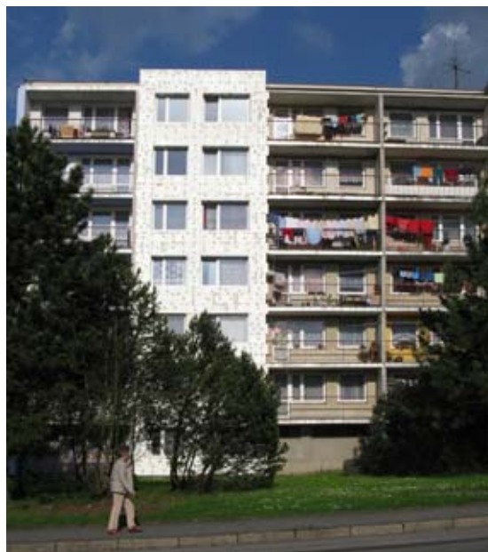
Obr. 31 Střídání sekcí s lodžielemi a bez nich má jen málo dobrých řešení průběhu tepelné izolace a žádné není levné.
