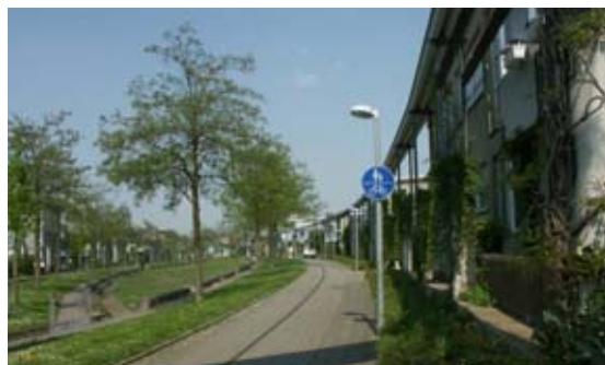
Obytný soubor Wohnpark Koppersbusch (Gelsenkirchen, Německo) – dešťová voda ze střech je sváděna visutým korytem (vpravo nahoře) neseným sloupky s popínavými rostlinami do vsakovacího prostoru ve středu souboru (vlevo dole), který je zároveň parkovou úpravou (foto Petr Klápště).
