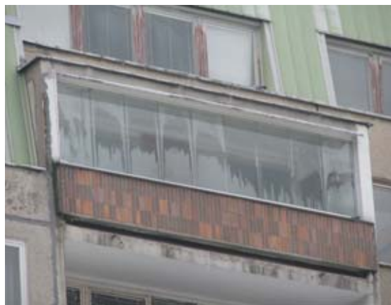
Obr. 44 Lákavá úprava vylepšení zasklení lodžie, zdroj EkoWATT.
