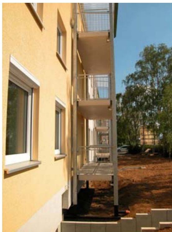
Obr. 9 Oddělená konstrukce balkonů, ocelová s betonovými podlahami u dokončené změny stavby, řešení bez tepelných mostů (zdroj CPD).
