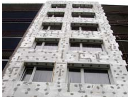
Obr. 6 Zateplení 100mm EPS lepené PUR lepicí pěnou s velkou spárou! Každá mezera nad 2mm by měla být pěnou dotěsněna.
