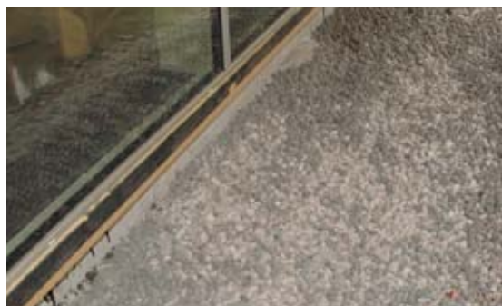
Izolace základů a podlahy pomocí štěrku ze skelné pěny
