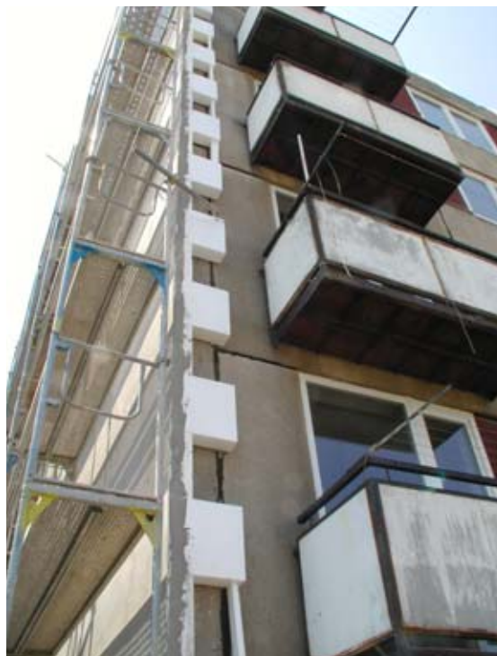
Stavební práce - nadstavba střechy (falešná atika) a izolování fasády polystyrenem - 16cm
