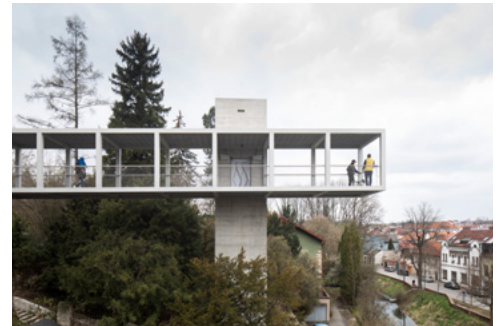
Lávka v Litomyšli / EHL & KOUMAR ARCHITEKTI (2022)
