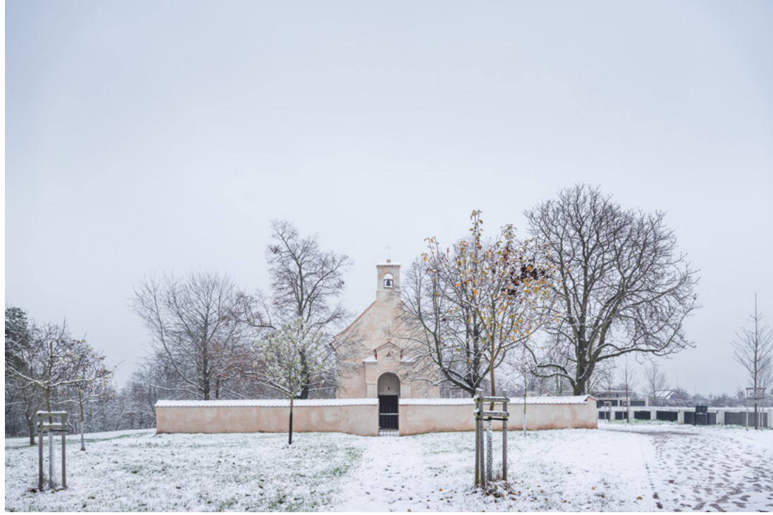
Nový průraz zdi ke kapli
