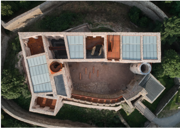
ČCA 2021 / CAA 2021 Atelier-r – Miroslav Pospíšil, Martin Karlík / Rekonstrukce paláce hradu Helfštýna / Helfštýn Castle Palace Reconstruction
