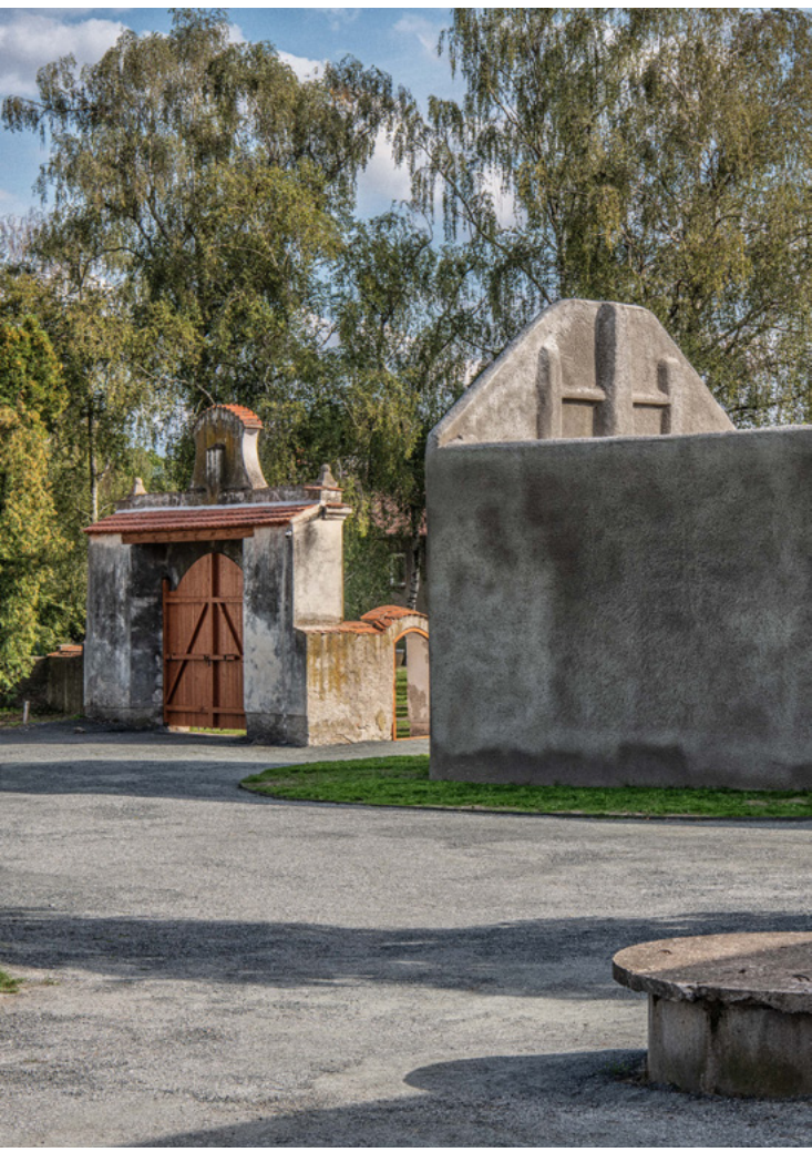
Barokní brána s obnovenými truhlářskými a tesařskými prvky
