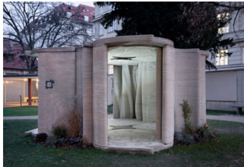
Mezi Konflikty, Praha / ICE Architects (2022)
