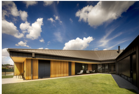
Rodinný dům pod Kunětickou horou, Dříteč / Med Pavlík architekti (2022)
