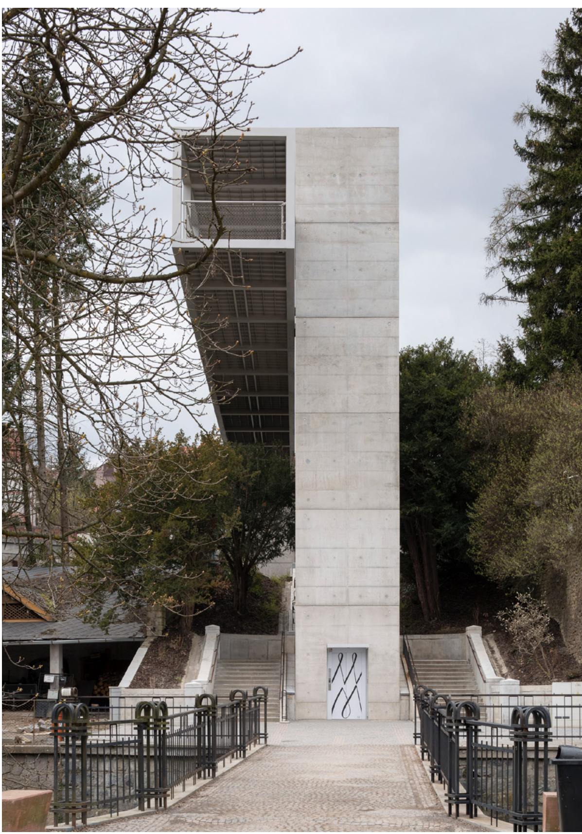
Pohled z mostu
