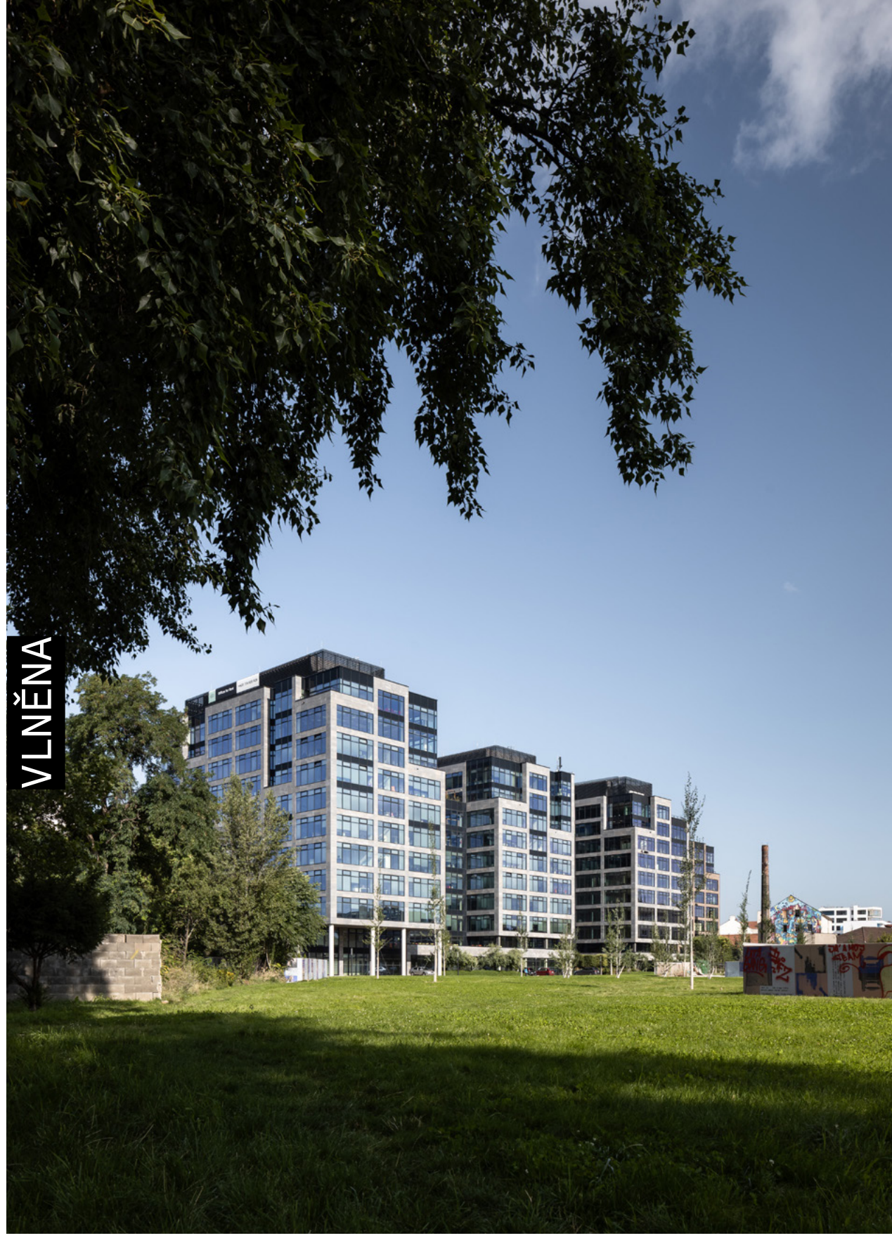
Budovy A, B, C – pohled od východu
