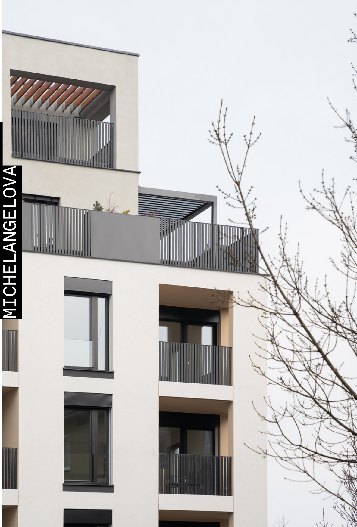
Detail jižní fasády
