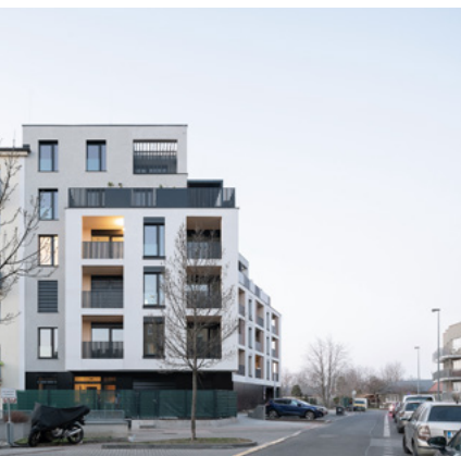
Pohled od jihu
