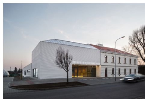
Městská hala Modřice / Atelier bod architekti, Studio A.B.S. (2020)
