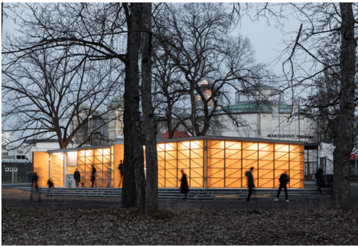
Pavilon je orientačním bodem na nově obnovené pěší cestě
