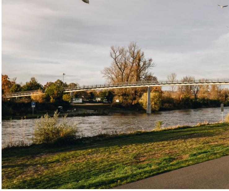
Pohled na lávku z Troji
