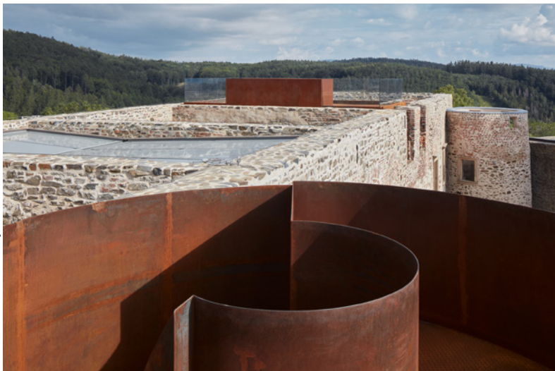
Pohled na střešní vyhlídku z vřetenového schodiště
