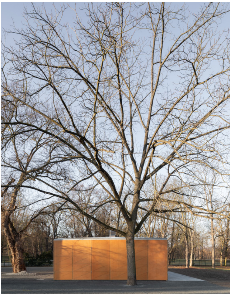
Pohled na zavřený pavilon od Výstaviště
