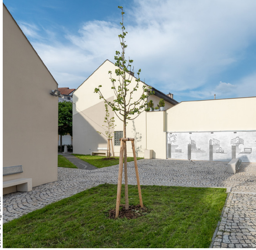
Stěna se sgrafitem
