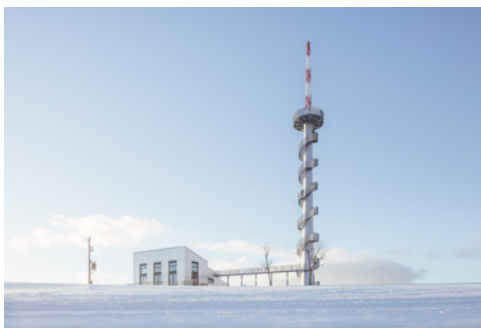
Rekonverze tubusu větrné elektrárny, Nový Hrádek / ABM architekti, PROJECTICON (2020)
