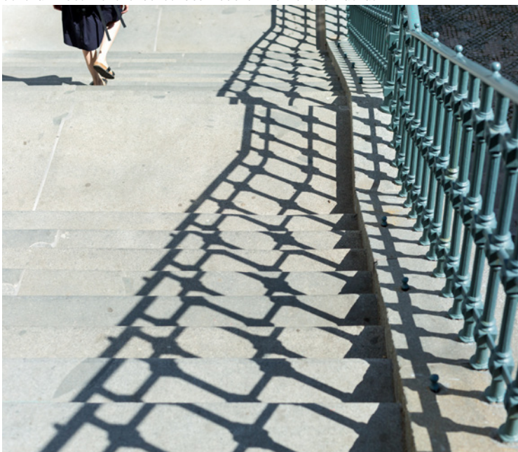
Obnova historického schodiště včetně litinového zábradlí
