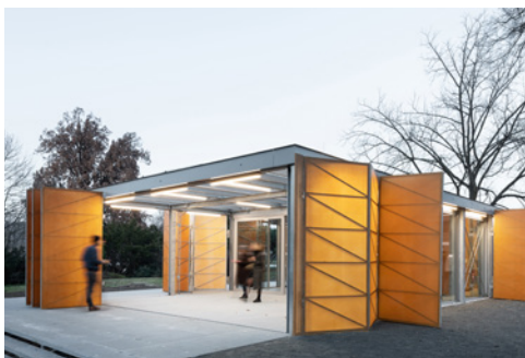
Pavilon na Výstavišti, Praha / PAPUNDEKL ARCHITEKTI (2020)
