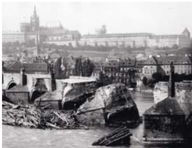
Protřzení mostních oblouků po povodni v roce 1890
