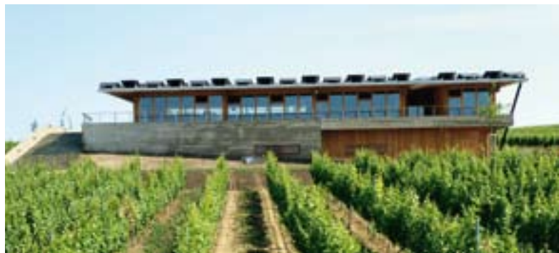
Vinařský dům Sonberg, Popice (autor: Ing. arch. Josef Pleskot, dřevostavba 35 kW, tepelné čerpadlo IVT Greenline 33 kW, odběr tepla z plošného kolektoru 1600 m 2 , podlahové vytápění, ohřev teplé vody – nerezový zásobník ACV 1000 I, chlazení pomocí fancoilů, zdrojem chladu je tepelné čerpadlo IVT)
