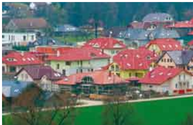
V případě nových obytných satelitů je kromě problematické architektonické úrovně zjevná „posedlost“ projektantů střechními okny, která vede k významným tepelným ztrátám a přehřívání podkrovní v létě.
