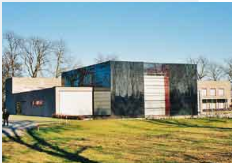
Farní kostel sv. Františka, autor: Architekten Luger & Maul, foto: Kateřina Mertenová
