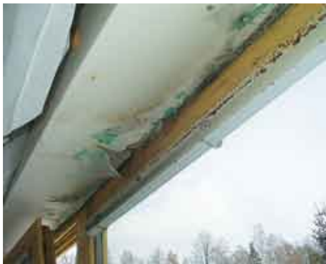
Grand Prix architektů 2000, Národní cena za architekturu, kolonka Rudník, Archteam Náchod. Standard nadpraží oken bytů po 5 letech od realizace. Aktuální situace je podstatně horší. Foto: Ivan Misar
