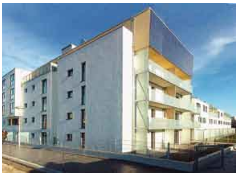
Martin Treberspurg / Treberspurg & Partner Architekten, pasivní bytový dům Roschégasse, Vídeň, Rakousko
