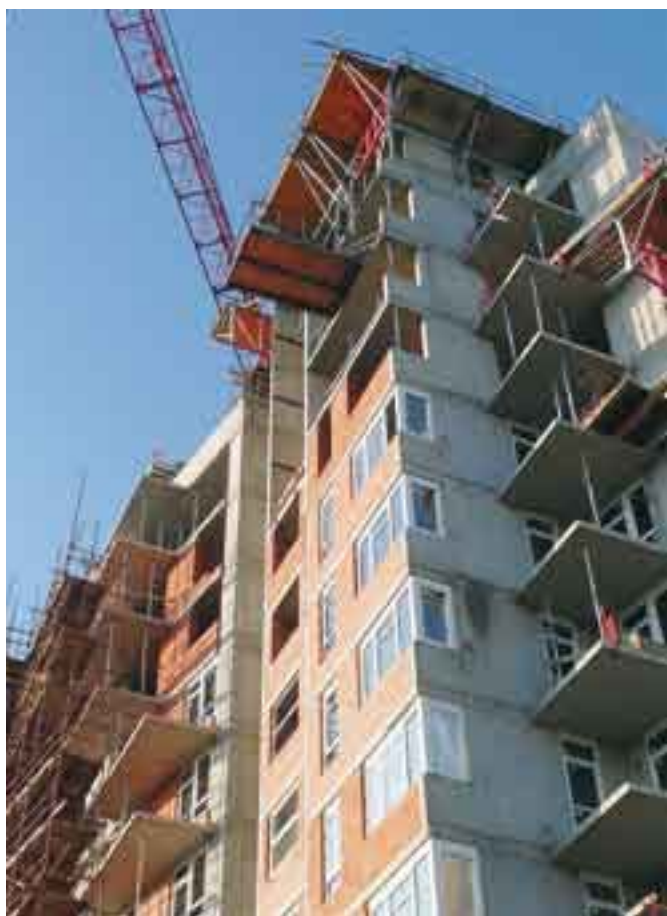
Modelový příklad typické developerské výstavby. Bytový dům, monolitický systém doplněn vyzdívkami. Plášť je přetažen několika centimetry minerální vlny, která během montáže několikrát zmokla. Dům, který nesplňuje elementární požadavky právních předpisů, je nabízen v realitách jako „kvalitní zděná stavba“.
