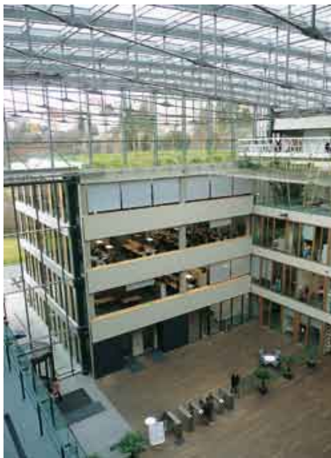
ČSOB Radlice. Pohled na plně prosklený vstupní portál a zastřešení vnitřní „julice“. Zajištění kvalitních parametrů vnitřního prostředí ve všech otevřených prostorách kancelářského typu „open space“ je zjevně mimo reálné technické možnosti TZB. Podlahová plocha 82 400 m 2 , dokončeno 2007, architekt: Josef Pleskot a kolektiv.
