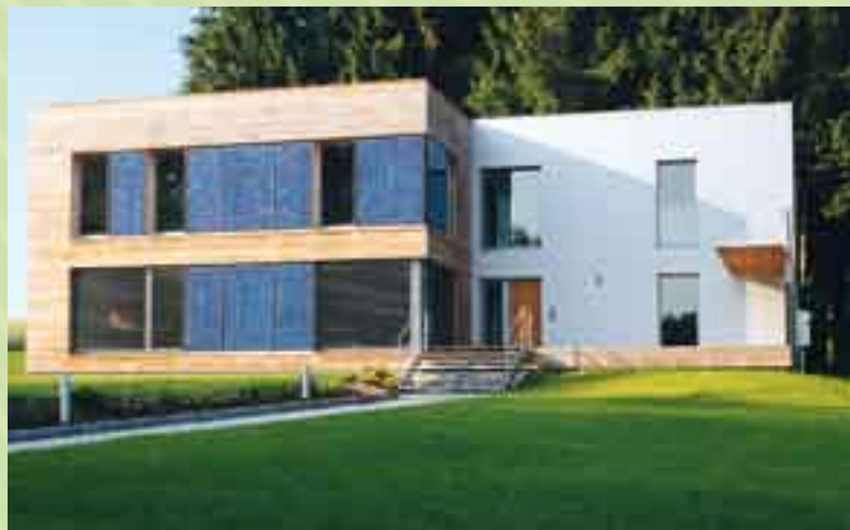
Rodinný dům v Pettenbachu, Rakousko / Günter Lang, LANG consulting, 2005, původní stav a změna na pasivní dům, foto archiv autora
