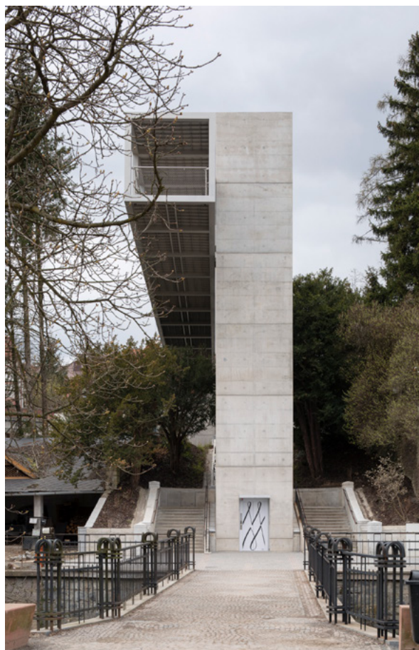
Pohled z mostu
