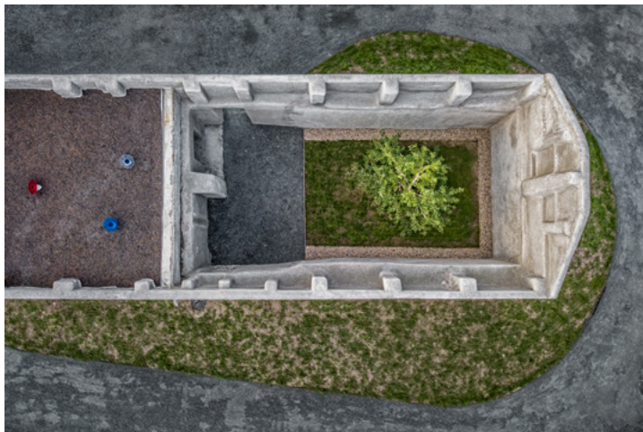
Dochované zdivo pod vrstvou stříkaného betonu
