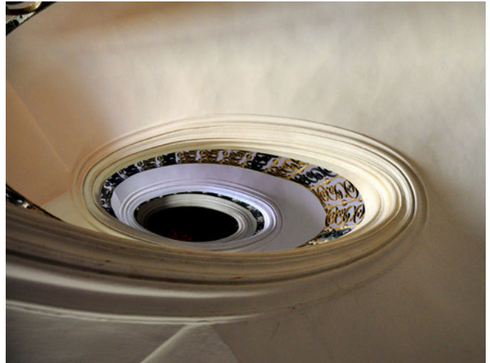
Klášteř Plasy – Santiniho eliptické samonosné schodiště. Foto Jirka Stejskal
