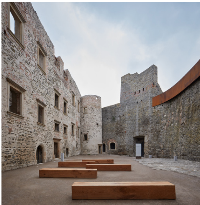
Rekonstrukce paláce hradu Helfštýn, atelier-r, Česká cena za architekturu 2021. Foto archiv ČKA
