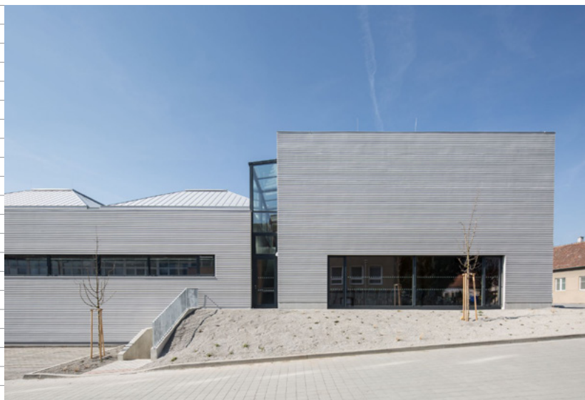
Vstupní objekt se salonkem a zrcadlovým sálem v patře
