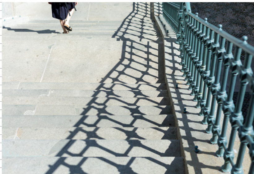
Obnova historického schodiště včetně litinového zábradlí
