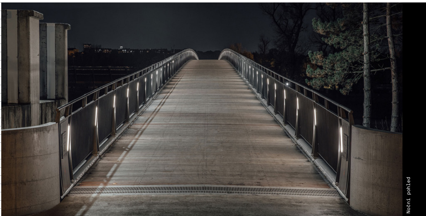
Pohled na lávku z Troji
