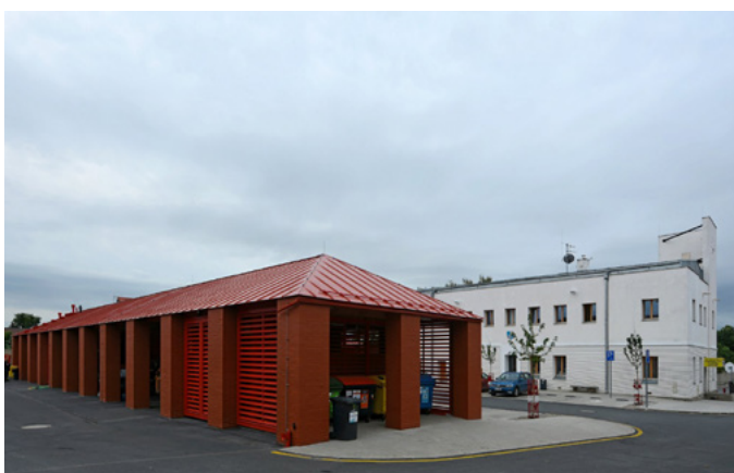
Hasičská stanice v Líbeznicích. Cena KZSP 2020. Foto archiv KZSP
