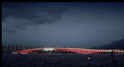
Čestné uznání Miroslav Hlava Danjiang Bridge FA ČVUT Praha doc. Ing. arch. Miloš Florián, Ph.D.
