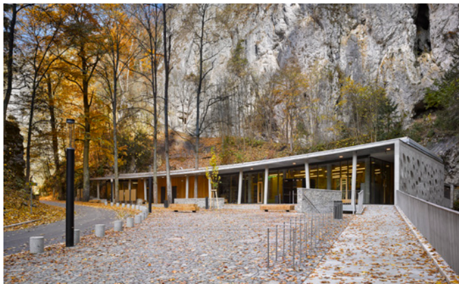
Vstupní budova areálu Punkevních jeskyní v Moravském krasu Architektonická kancelář Burian-Křivinka
