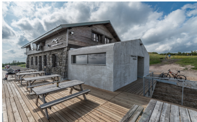
Rekonstrukce a přístavba Vrbatovy boudy v Krkonoších IXA - Tomáš Hradečný, Martin Prokš, Klára Hradečná, Benedikt Markel
