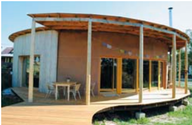
Pasivní kruhový dům v Rapotících v okrese Brno-venkov, autor Mojmir Hudec. Stavba je řešena jako energeticky úsporný dům s použitím přírodních materiálů – dřeva, slaměných balíků a hliněných omítek. Objekt je kruhový se zelenou střechou se stíněním jižní strany přesahem střechy.
