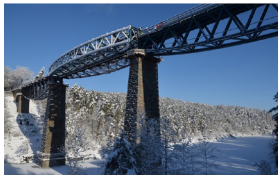
Rekonstrukce mostu v km 1,429 trati Pňovany – Bezdržice (investor: Správa železnic, státní organizace; autoři: Ondřej Lojík; projekt: TOP CON SERVIS, s. r. o.; dodavatel: Společnost SMP-MCE-Pňovany-Bezdržice / SMP CZ, a. s.; MCE Slaný, s. r. o.)
