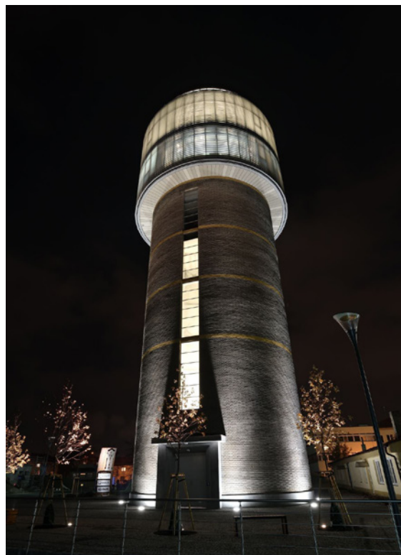
VSC Veolia Smart Control Tower-Kladno (investor: Středočeské vodárny, a. s.; autoři: Tereza Tejkalová, Michal Škrna; projekt: D-plus, projektová a inženýrská, a. s.; dodavatel: JOPO CONSTRUCTIONS, a. s.)
