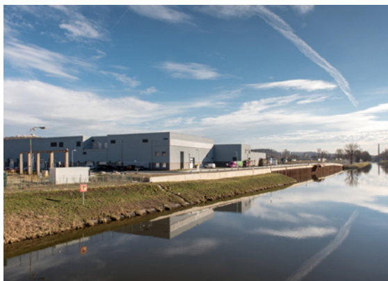
Celková přestavba a rozšíření ÚčOV Praha na Císařském ostrově, autor: Sweco Hydroprojekt, a. s., investor: Hlavní město Praha
