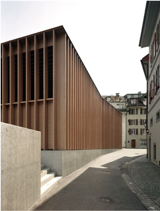
Miller Maranta Architekten, Tržnice na Färberplatz v historickém centru města Aarau, 2002. Foto Ruedi Walti
