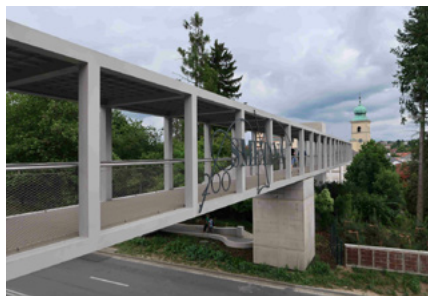
Lávka s výtahem v Litomyšli
