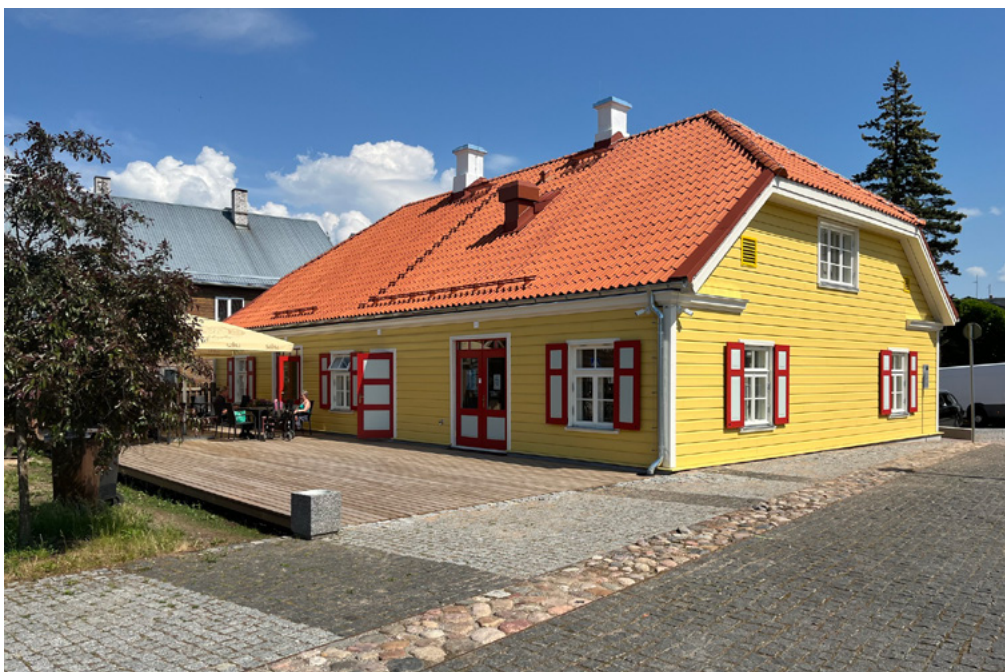
Nejstarší zachovaná dřevěná budova po rekonstrukci 2024, kde vznikly nebytové prostory, které obec pronajímá.
