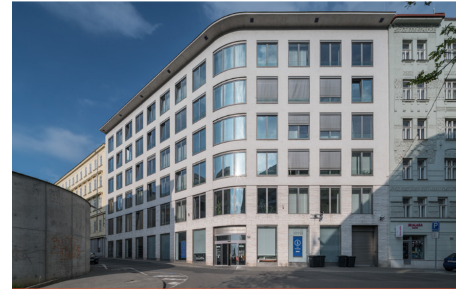
Správní budova Dopravního podniku města Brna
