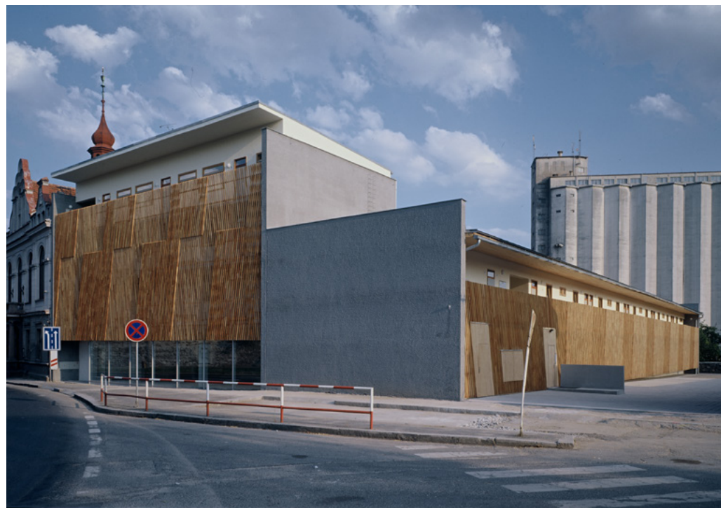
Dům se startovními byty v Horažďovicích
