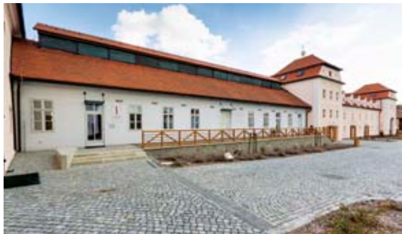
Rekonstrukce bývalých hospodářských budov, konírny a sýpky na Velehradě / Jan Dvořák, Michaela Dvořáková, účast GPA 2012, foto archiv autorů
