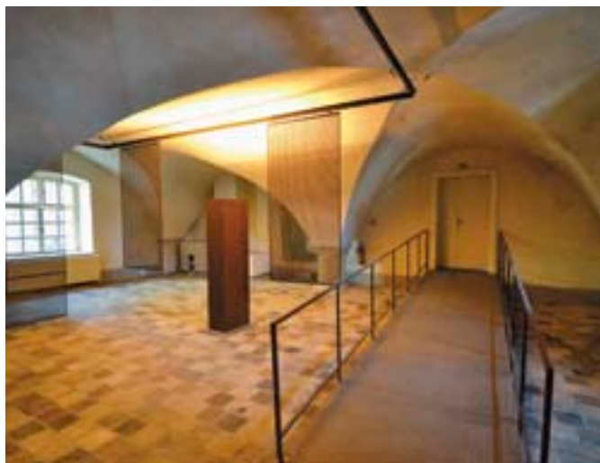
Obnova a restaurování bývalé renesanční sladovny v Žatčíně / Jiří Vaniček, Petr Bažant, Pavel Huml, Karel Hrách, účast GPA 2012, foto archiv autorů
