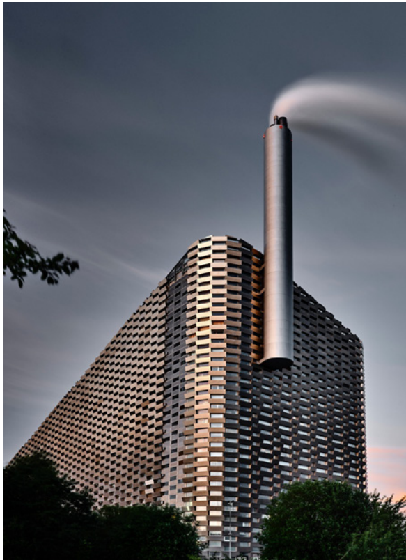
Bjarke Ingels Group / BIG Architects. ZEVO Amager Bakke v Kodani. Soutěž 2011, realizace 2018. Foto archiv Amager Bakke
