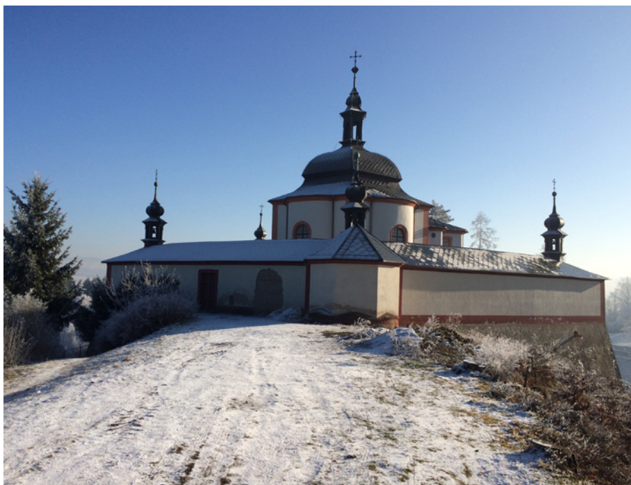
Kaple sv. Jana Nepomuckého nad Letohradem prochází již od roku 2010 rozsáhlou obnovou.
