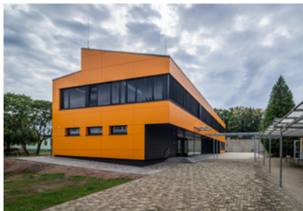
Výstavba pavilonu základní školy Tuchlovice STAVAŘI Kateřina Horáková 2020
