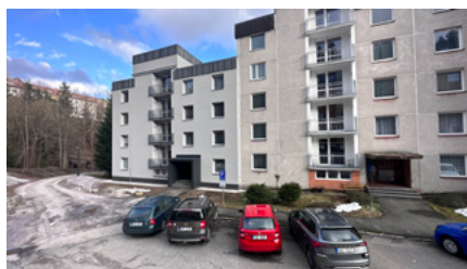
Stavební úpravy a zateplení bytového domu Bedřichov 105, Špindlerův Mlýn
