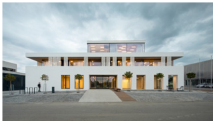
Dům služeb v Palkovicích
