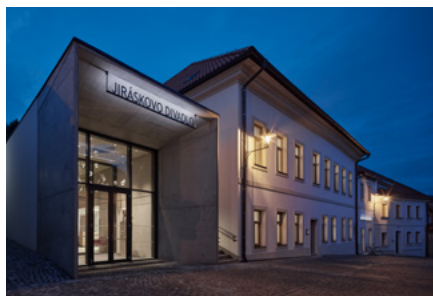
Rekonstrukce Jiráskova divadla v České Lípě
