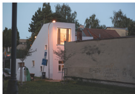
18.DESÁTKOVÁ – renovace rodinného domu v Brně
