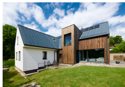
Stavební úpravy a přístavba rodinného domu, Soustov
