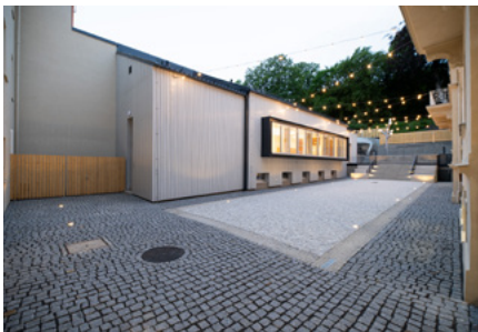
Celková rekonstrukce domu Chopin, Mariánské Lázně ARCHITEKT Ondřej Tuček Ondřej Tuček, Lenka Belanská, Matouš Štrba 2023
