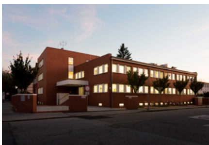
Rekonstrukce budovy Vodohospodářské laboratoře Povodí Vltavy, České Budějovice
