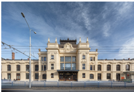
Rekonstrukce vlakového nádraží v Českých Budějovicích
