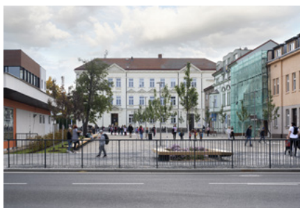
Rekonstrukce Komenského náměstí v Dobříši
