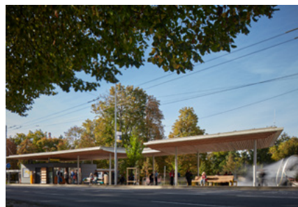
Rekonstrukce tržiště Pod Kaštany ve Zlíně
