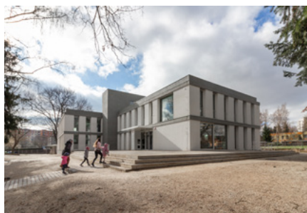
19.Chodov – přestavba bývalé výroby knedlíků na městskou knihovnu, Chodov Ateliér Kopecký Jan Kopecký, Mojmír Kopecký, Tomáš Kopecký 2023
