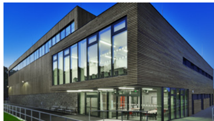
Novostavba multifunkční sportovní haly Třebovice, Ostrava
