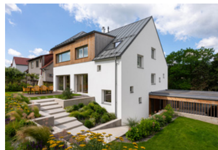
Rekonstrukce rodinného domu v Blansku
