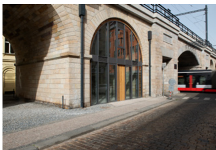
Negrelliho viadukt – příležitost pro kreativní město 036, Praha 8
