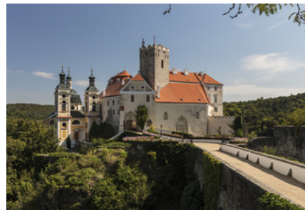
Obnova a konverze strážní věže zámku Vranov nad Dyjí
