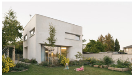
Dům v kostce, Praha-Radotín
