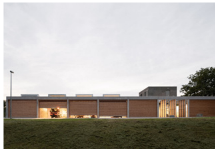
Základna technických služeb, Praha-Lysolaje
