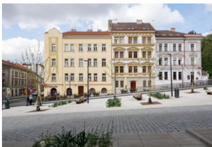
Obnova Tachovského náměstí, Praha
