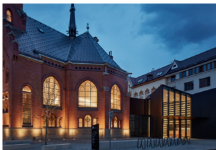
Obnova Červeného kostela, Olomouc
