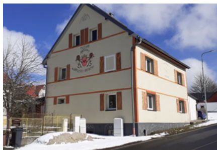
Rekonstrukce fasády, Abertamy
