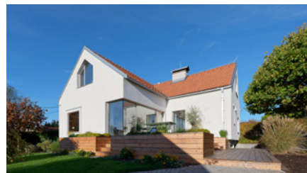
Přestavba rodinného domu v Ostrovačicích
