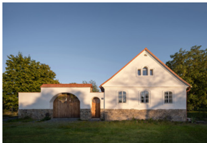
Rekonstrukce venkovského stavení, Kladruby
