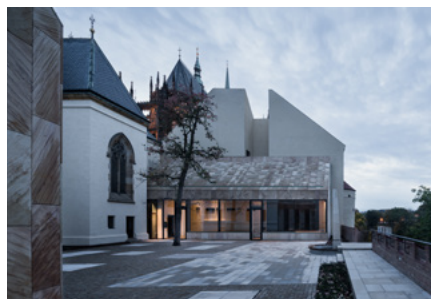
Přístavby a rekonstrukce Nového proboštství, Praha 1-Hradčany
