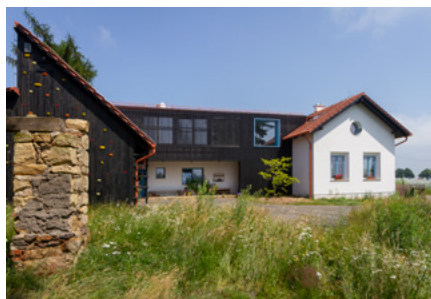
Rekonstrukce venkovské usedlosti, Chotěboř
