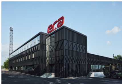
Rekonstrukce a přístavba výrobní budovy Era, Pardubice
