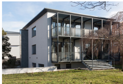
Přestavba dvougenerační vily v Akademické vesnici Praha-Krč
