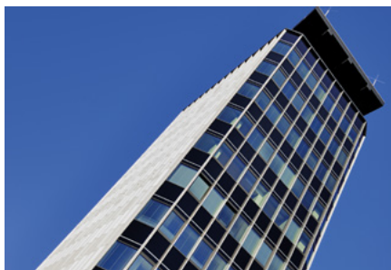
Rekonstrukce administrativní budovy Černá perla, Ostrava
