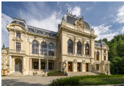
Revitalizace objektu Císařských lázní, Karlovy Vary
