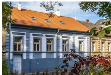
Rekonstrukce domu v Praze 6-Liboci
