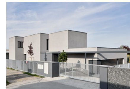
Dům v Kolodějích, Praha
