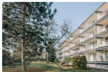
Rozšíření lodžii panelového domu, Praha
