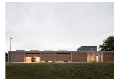
Základna technických služeb, Praha-Lysolaje
