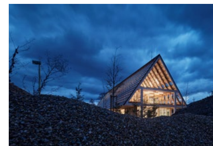
Sídlo Kloboucké lesní, Brumov-Bylnice
