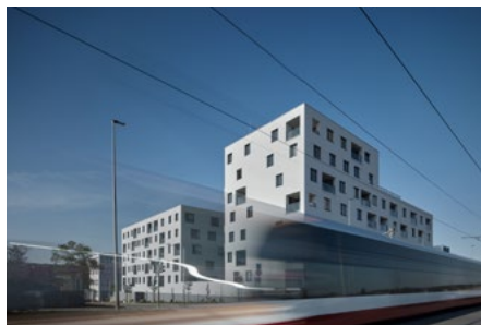
NOVÁ ELEKTRA, Praha 9-Hloubětín
