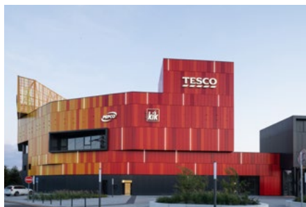
Revitalizace OC FUTURUM, Brno
