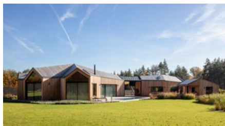
Vesnické stavení v Hoděšovicích, Býšť
