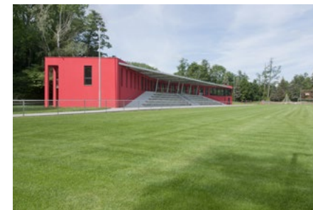
Rekonstrukce sportovního areálu v obci Radim – 1. etapa
