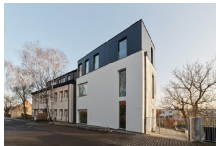
Dostavba a rekonstrukce základní a mateřské školy v Úněticích
