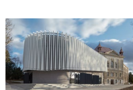
Nové výukové centrum VŠPJ, Jihlava
