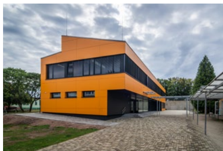
Výstavba pavilonu základní školy Tuchlovice
