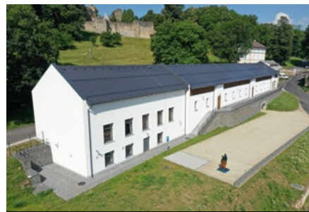
Stavební úpravy galerie Klenová č. p. 3, Klenová
