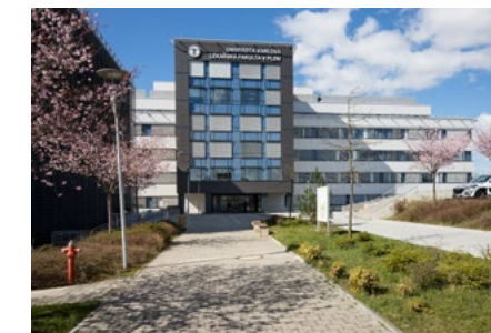
LF UK v Plzni – Univerzitní medicínské centrum (UniMeC) – II.etapa, Plzeň
