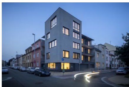
Nájemní bytový dům, Pardubice
