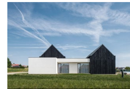
Dům dvě věže, Dolní Bojanovice
