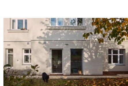
Terasa suterénního bytu, Praha Střešovice
