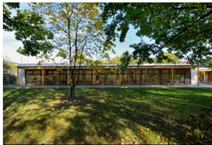
Přestavba bývalých jeslí, Opava
