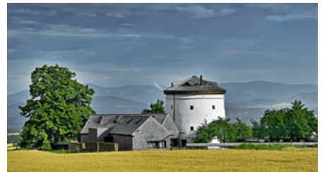
Rekonstrukce a přístavba objektu pro bydlení, Vrchpolí, Zbyslavice, Ostrava-město
