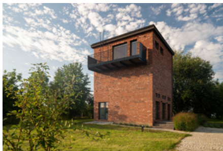
Obnova Trafostanice, Vyškov
