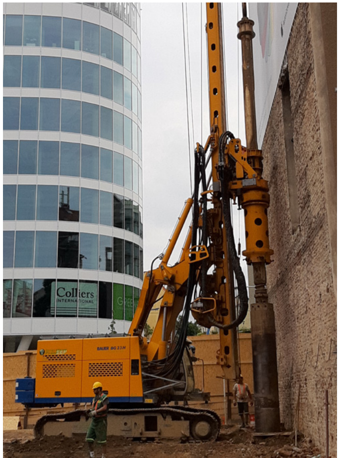
Provádění vrtů podél stávající stavby. Foto archiv autora
