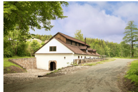
Revitalizace NKP Vodní Hamr Dobřív
