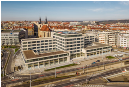
Palác elektrických podniků – rekonstrukce a konverze, Praha
