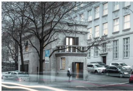
Trafo Smíchov ASA 400 Gallery, Praha 5
