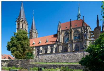
Revitalizace areálu kostela sv. Bartoloměje v Kolíně
