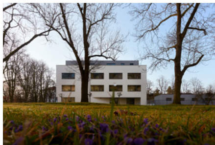
Polyfunkční dům nad předávací stanicí A43, Hradec Králové
