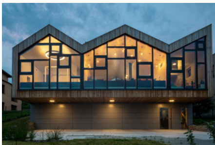
Átriový dům ve svahu, Plzeň
