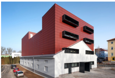
Rozšíření depozitárních prostor – Bory 16, Plzeň
