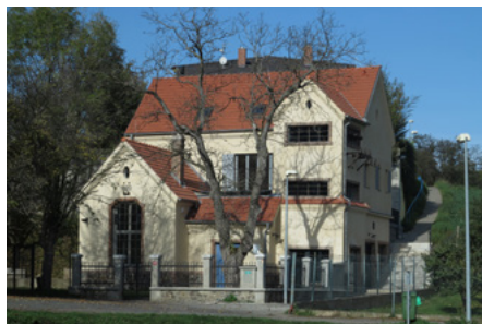
Rekonstrukce Staré vodárny v Nebušicích na komunitní centrum městské části
