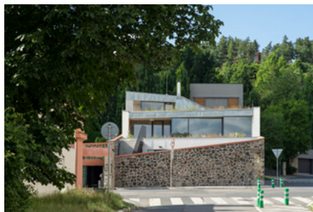
Bytový dům U Vinice, Praha 8-Troja
