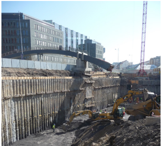
Karlín – převrtávaná pilotová stěna
