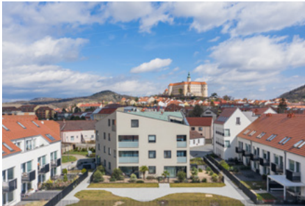
Obytný soubor – Speicher 1826, Mikulov
