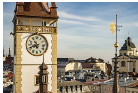
Radnice Olomouc – stavební práce na objektu kulturní památky, oprava věže
