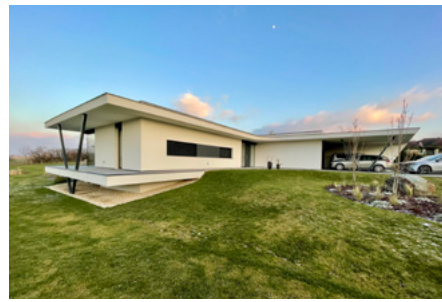
Novostavba rodinného domu v Sobělicích, Rataje-Sobělice
