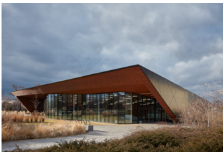
Městská plavecká hala Louny
