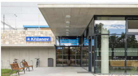
Rekonstrukce a optimalizace budovy železniční stanice, Křižanov / Kozlov u Křižanova
