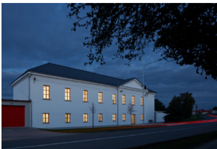
Úprava objektu obecního úřadu Hlučov
