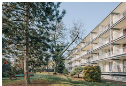
Rozšíření lodžii panelového domu, Praha
