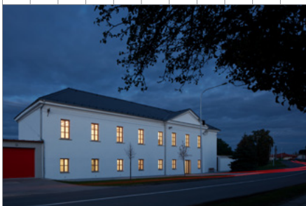
Rekonstrukce obecního úřadu, Hlučov 2
