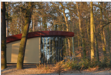
Úpravná vody – obnova vrátnice, Plzeň
