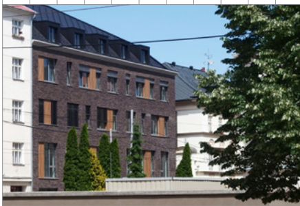
Polyfunkční dům Sokolská 5, Olomouc
