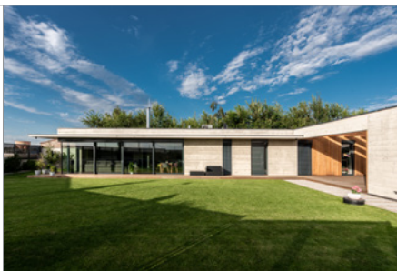
Betonový rodinný dům, Ořechov
