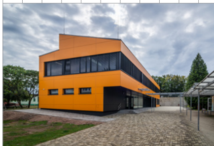
Výstavba pavilonu základní školy, Tuchlovice
