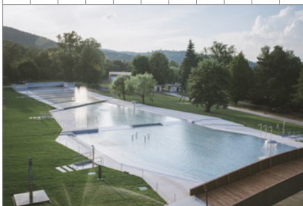
Rekonstrukce bazénů koupaliště Riviéra, Brno
