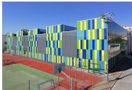
Dostavba víceúčelové sportovní haly v areálu městské sportovní haly na Slovanech, Plzeň
