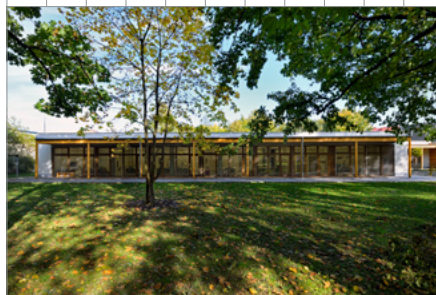
Přestavba bývalých Jeslí, Opava
