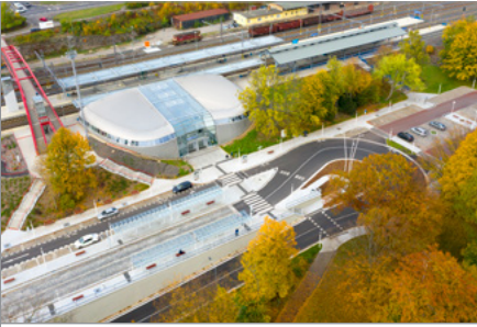
Modernizace ŽST. Karlovy Vary – nová výpravní budova, staniční část a prostor přednádraží, Karlovy Vary
