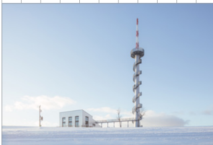
Rekonverze tubusu větrné elektrárny, Nový Hrádek
