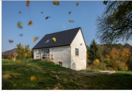
Špejchar – rekonstrukce a přestavba na bydlení, Českolipsko
