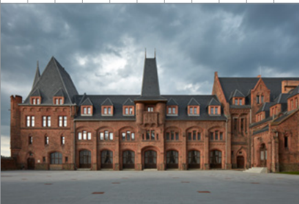
Památková obnova Červeného zámku, Hradec nad Moravicí
