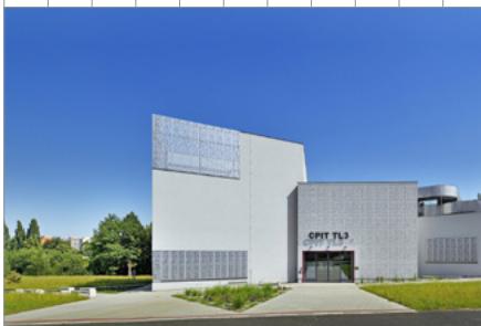
Platforma nových technologií FEI CPIT TL3, Ostrava
