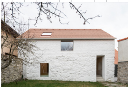
Dům na Kozině, Trhové Sviny
