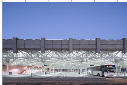
Ústřední autobusové nádraží Zvonařka, Brno
