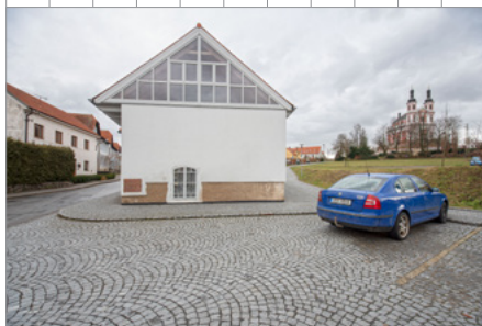
Rekonstrukce objektu č. p. 116 na volnočasové centrum, Luže
