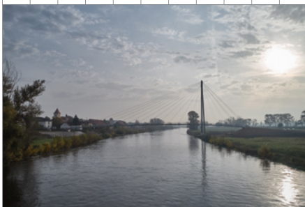
Lávka přes Vltavu v Lužci nad Vltavou
