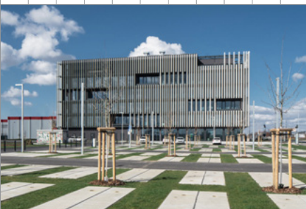
Administrativní budova firmy Konplan, Plzeň
