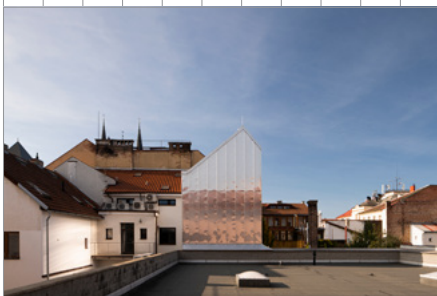
Přístavba kanceláře ve Vysokém Mýtě
