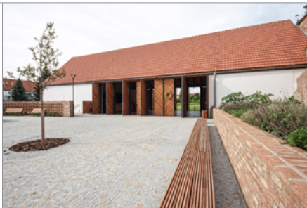
Komunitní centrum, Židlochovice
