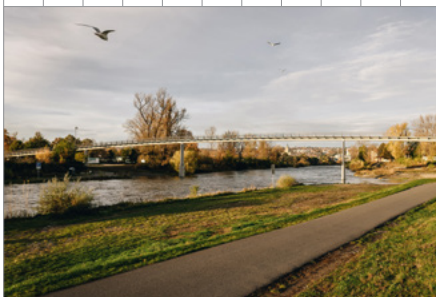
Nová Trojská lávka, Praha 7
