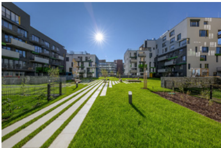
Obytný soubor 4BLOK, Praha-Vršovice
