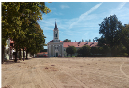
Rekonstrukce části Národního hřebčína Kladruby nad Labem
