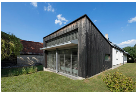
Rekonstrukce rodinného domu, Machov
