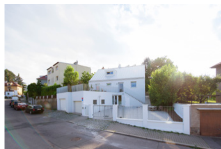
Rekonstrukce domu typu Okál, Praha 4
