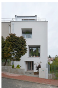
Přestavba rodinného domu na ulici Palouk, Brno
