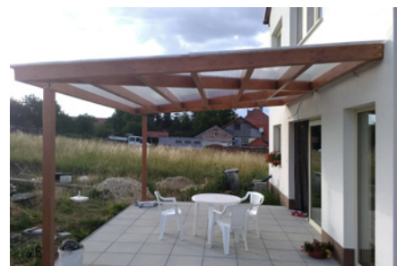
Zastřešení terasy rodinného domu, Vlčnov
