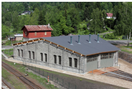
Rekonstrukce výtopyň Kořenov
