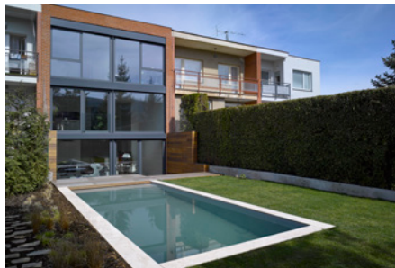
Přestavba řadového domu, Praha 6
