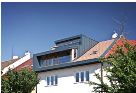
Rekonstrukce podkroví, B. Němcové, Brno
