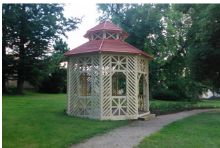
Zámek Hořovice - obnova zahradního altánu
