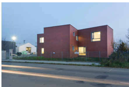
Administrativní budova Rapos, Holešov
