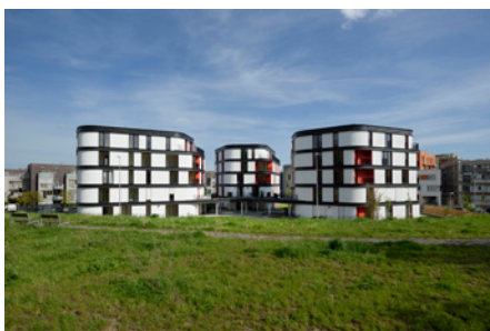
Bytové domy VACKOV - etapa D, Praha 3
