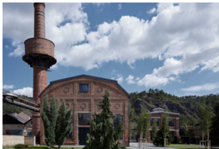
Kotelna Libčice nad Vltavou
