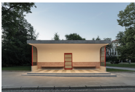
Rekonstrukce funkcionalistické zastávky od architekta Oskara Poříšky v Brně na Obilním trhu
