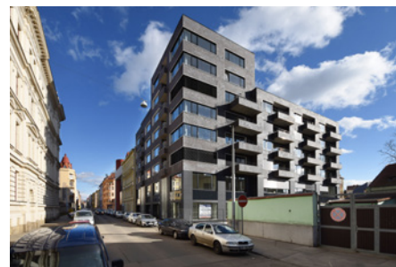
Polyfunkční dům Bratislavská, Brno
