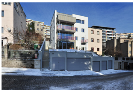
Viladům K Vodojemu, Praha 5
