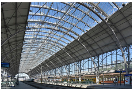
Rekonstrukce ocelové haly hlavního nádraží, Praha
