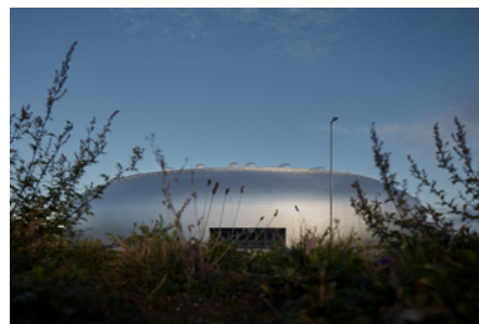
Sportovní hala Dolní Břežany
