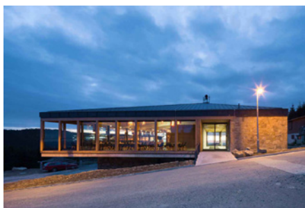
Výstupní stanice lanové dráhy na Pustevnách, Trojanovice
