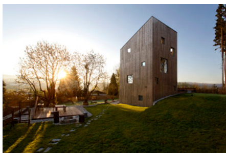
Dům v Čižicích, Štěnovice
