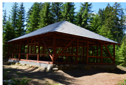
Zastřešení zaniklé brusírný skla, Stará Knižecí Huť
