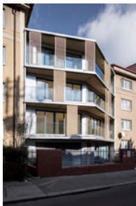
Bytový dům Mydlářka, Praha 6-Dejvice
