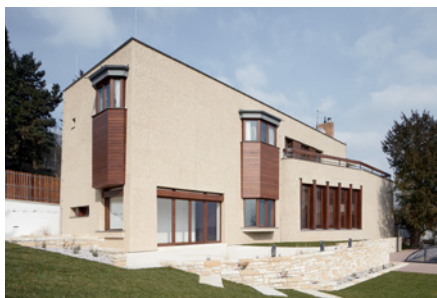
Rekonstrukce funkcionalistické vily Indiánská loď, Praha
