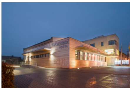
Areál obecního úřadu Ostrožská Nová Ves
