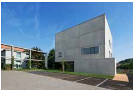
Přístavba laboratoří a počítačového centra CzechGlobe
