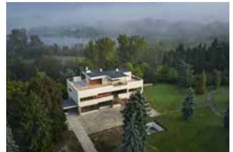
Rekonstrukce Volmanovy vily, Čelákovice - Tichý & Kolářová Marek Tichý, Magdalena Kurfurstová, Jan Tomeš - 2015/08
