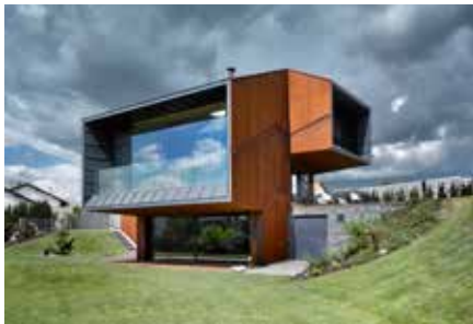
Vila severně od Prahy, Horoměřice - VÝŠEHRAD atelier Jiří Smolík, Tereza Mandíková, Zdeněk Rychtařík, Martin Šafránek, Pavel Marek - 2014/07
