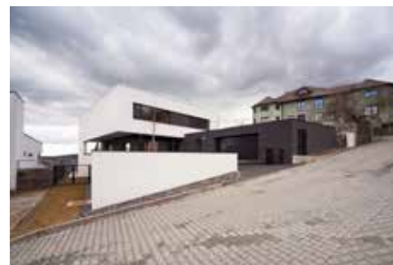
Vila s výhledem, Brno - Fundament Architects Pavel Lazarov, Václav Kocián - 2015/12
