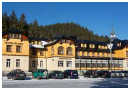
Rekonstrukce hotelu Pokrok Bílá, wellness hotelu Pokrok, Bílá Staré Hamry
