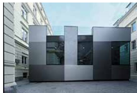
Balneo a wellness - rekonstrukce a dostavba Grandhotelu Pupp, Karlovy Vary - Architektonický atelier Kaama Karel Mrázek, Tereza Štumpfová - 2013/03
