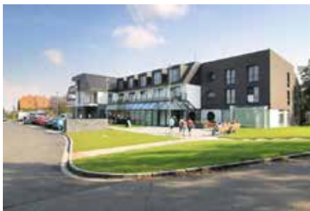
Dostavba LD Balnea, Slatinice - Jan Přikryl, Architektonická kancelář Jan Přikryl - 2014/06
