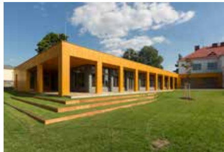
Přístavba 2 odd. MŠ Zámecké náměstí, Velká Bystrice - SBORWITZ architekti Michal Sborwitz, Marie Sborwitzová, Karel Prášil - 2015/01
