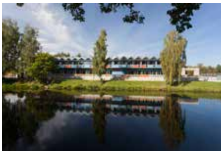
Administrativní budova Povodí Vltavy, České Budějovice
