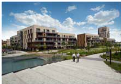
Rezidenční Park Baarova, Praha
