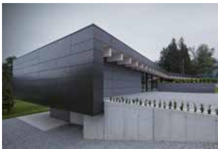
Rekreační objekt, Čeladná - CMC architects Vít Máslo, David R. Chisholm - 2015/09
