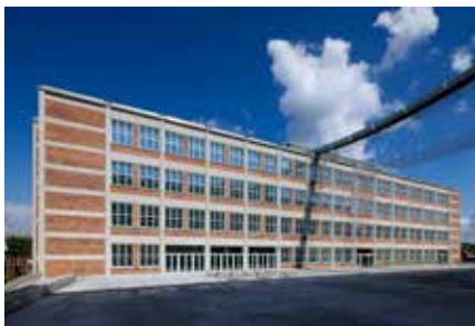
14|15 Bařův Institut, Zlín - CITY WORK Juraj Sonlajtner, Jakub Obůrka (autoři stavby); Petr Vřetečka, Robert Václavík, Karel Menřík (autoři stálých expozic) - 2013/07
