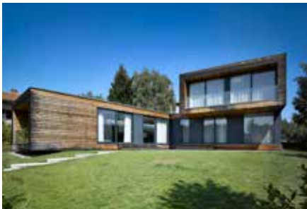
Rodinný dům v Černošicích - VYŠEHRAD atelier Pavel Marek, Zdeněk Rychtařík, Martin Šafránek, Jiří Smolík - 2012/03
