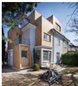
Rekonstrukce rodinného domu v Brně
