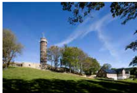
Maják a Muzeum Járy Cimrmana, Příchovice, Kořenov - Huť architektury Martin Rajniš Martin Rajniš, David Kubík - 2013/06
