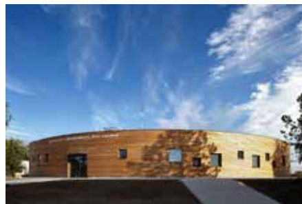
Pavilon základní školy, Libeznice - Projektili Architekti Adam Halíř, Ondřej Hofmeister, Petr Lešek, Roman Brychta, Marek Sankot, Bohdana Linhartová - 2015/08
