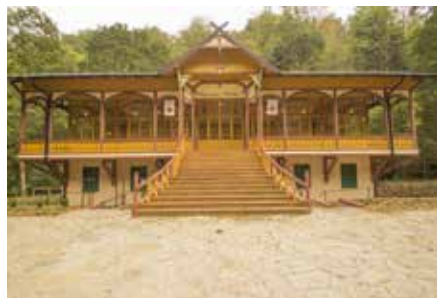
Rekonstrukce Tančírny v Račím údolí - SBORWITZ architekti Michal Sborwitz, Marie Sborwitzová, Karel Prášil - 2015/07
