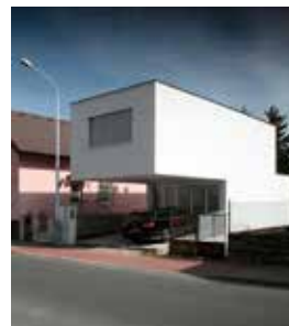
Vila Dobeš, Praha - under-construction architects Vladimír Vašut, Erika Vašutová - 2012/03
