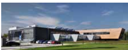
Univerzitní centrum energeticky efektivních budov ČVUT v Praze, Buštěhrad - Šenbergerová, Šenberger - architekti Tomáš Šenberger, Tomáš Med - 2014/02
