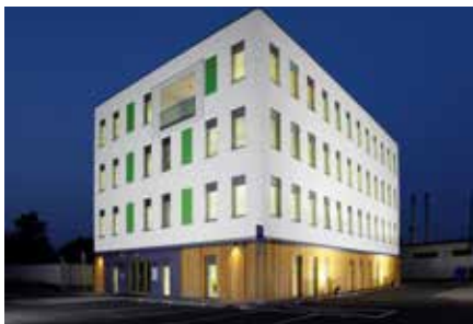
Otazník, První pasivní administrativní budova v České republice, Ostrava-Hulváky - ATOS-6, stavebně projektová kancelář Radim Václavík - 2011/09
