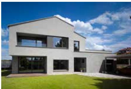
Rekonstrukce rodinného domu v Klánovicích - VYŠEHRAD atelier Zdeněk Rychtařík, Pavel Marek, Tereza Mandíková, Jiří Smolík, Martin Šafránek - 2012/01
