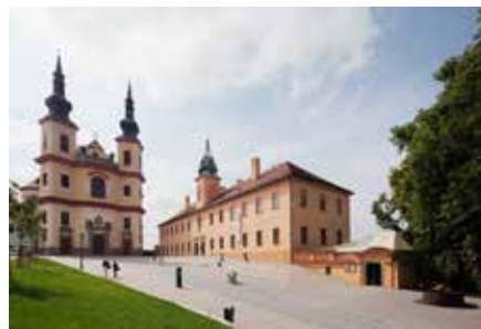
Revitalizace zámeckého návrší v Litomyšli - AP atelier Josef Pleskot, Jiří Vlach, Andrej Škripeň, David Ambros, Marek Barták, Daniel Kříž - 2014
