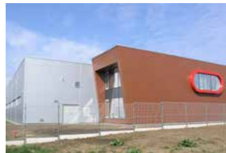
Výrobní hala s administrativou, Brno – ATELIER X, Architect c Engineers Jan Zezúlka – 2015/12
