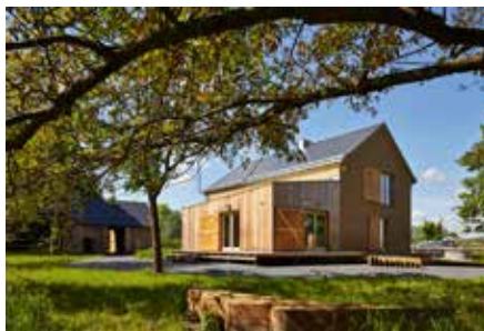
Dům přírody Litovelského Pomoraví, Horka nad Moravou – Projektil Architekti Petr Lešek, Ondřej Hofmeister, Adam Haliř, Roman Brychta, Marek Sankot, Tomáš Bouma, Helena Hejdová – 2014/09
