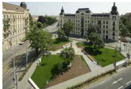
Rekonstrukce centrální části Konečného náměstí – TIVOLI, Brno – P.P. Architects Pavel Pekár, Marek Holán, Ondřej Mundl, Tomáš Págo – 2015/05
