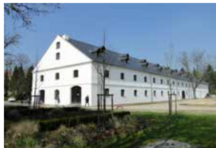
Pevnost poznání – rekonstrukce dělostřeleckého skladu na vědecké muzeum, Olomouc – Ateliér Bonmot Stašek Žerava, Miroslav Procházka – 2014/12
