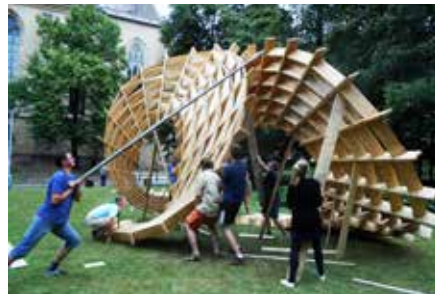
LOOP - Environmentální letní pavilon II, Praha - Collaborative Collective, Fakulta umění a architektury na Technické Univerzitě v Liberci, Fakulta lesnická a dřevařská na České zemědělské univerzitě, Fakulta architektury na Českém vysokém učení technickém v Praze, ARCHWERK - 2014/06
