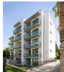
Bytový dům Kadetka, Brno-Královo Pole - Atelier RAW Tomáš Rusín - 2015/01
