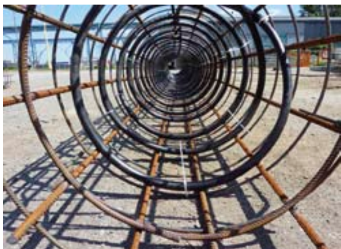
Vyrobená energetická pilota připravená pro uložení do vrtu a následné zabetonování
