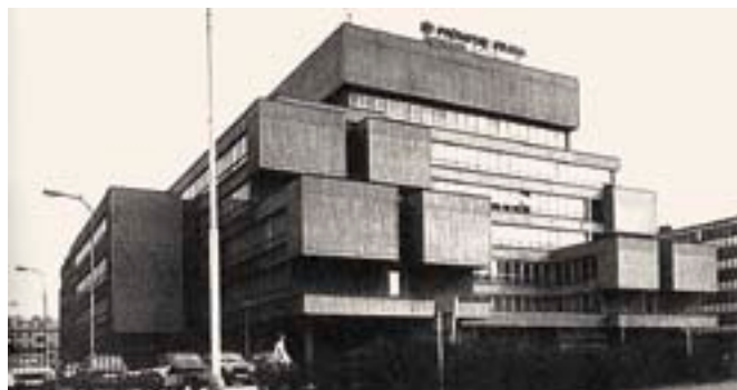
Administrativní budova Průmstav, Štětškova ulice v Praze, 1976
