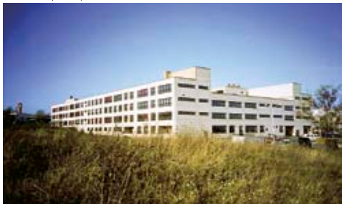
SPŠ stavební v Praze 4
