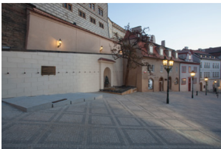
Rekonstrukce horní části Nerudovy ulice, Praha 1
