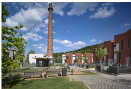
Top rezidence Šárecké údolí, Praha 6
