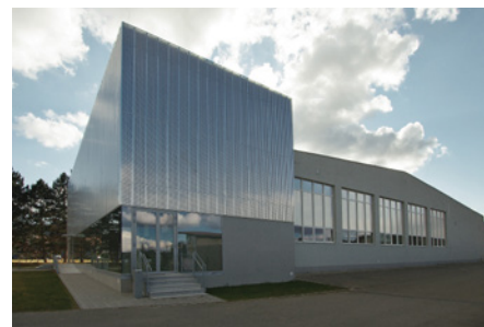
Dostavba tělocvičny ve sportovním areálu, Palkovice
