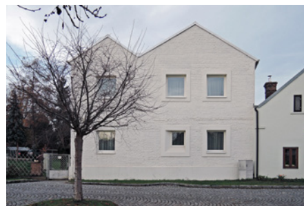
Rekonstrukce domu v „Ráji“, Lázně Bohdaneč
