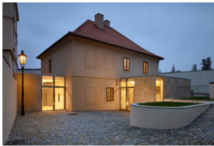
Rekonstrukce fary u kostela sv. Gotharda, Praha 6-Bubeneč
