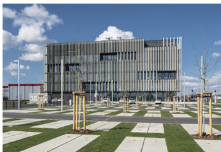
Nová administrativní budova firmy Konplan, Plzeň
