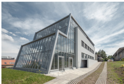
Rekonstrukce budovy pro odbornou výuku Střední školy zahradnické a technické, Litomyšl
