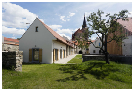
Stavební úpravy fary na ubytovací zařízení pro osoby s poruchami autistického spektra, Chvalšiny
