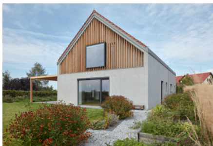
Přestavba rodinného domu, Hrusice
