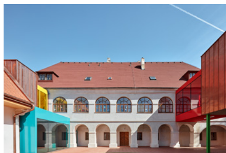
Rekonstrukce a rozšíření ZŠ, Vřesovice u Prostějova
