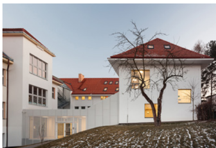
Základní škola Jára Cimrmana, Praha-Lysolaje
