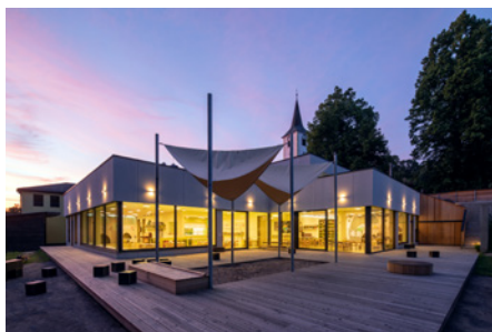
Mateřská školka a přístavba jídelny k základní škole, Nekoř
