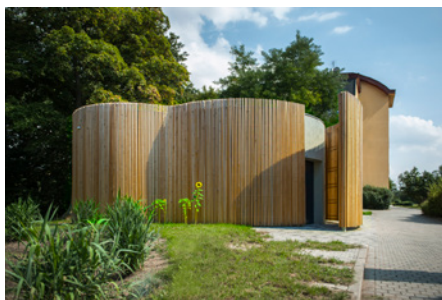
Veřejné WC, Praha-Uhřetěves
