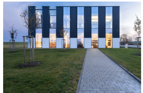
Hala s administrativou, Milevsko
