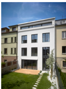
Přestavba řadového domu, Praha
