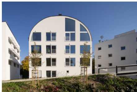
Corso Pod Lipami, Řevnice
