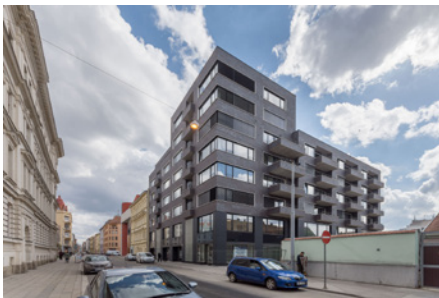
Polyfunkční dům Bratislavská, Brno
