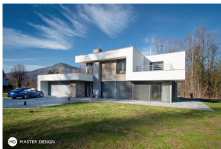
Novostavba rodinného domu, Čeladná
