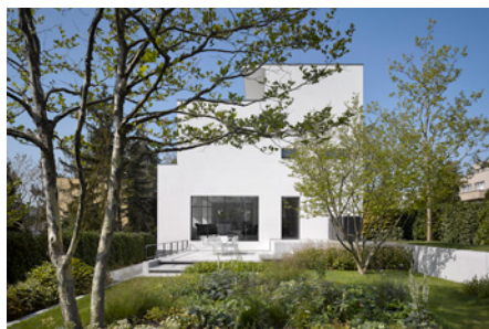
Rekonstrukce vily Košťál na Babě, Praha 6
