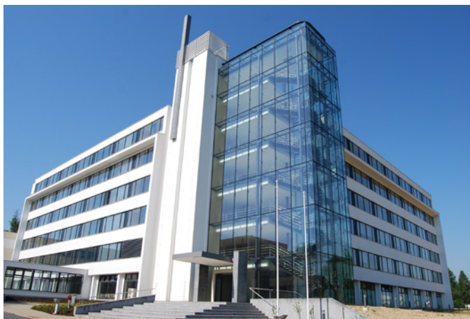
Pavilon velkých poslucháren, Fakulta stavební, Vysoká škola báňská, TU Ostrava. Místo konání konference Architektura v perspektivě 2019. Foto archiv FAST VŠB – TU Ostrava
