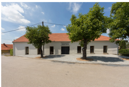
Rekonstrukce hospody se sálem, Málovice
