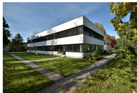
Rekonstrukce RESTLESS, Opava
