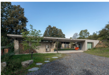
Přístavba rodinného domu, Kojetín u Nového Jičína
