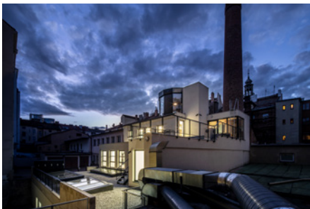
Bývalá výrobní uzenin, Praha-Nusle
