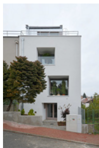
Rekonstrukce rodinného domu, Brno
