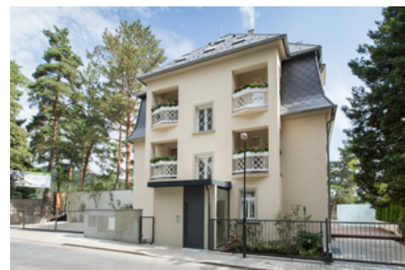
Terasy Lázeňský vrch – rekonstrukce vily nad jezerem, Staré Splavy
