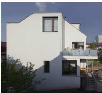
Přístavba a stavební úpravy řadového rodinného domu Jiřinková, Praha 10
