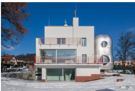
Rekonstrukce a dostavba prvorepublikové vily, Pyšely
