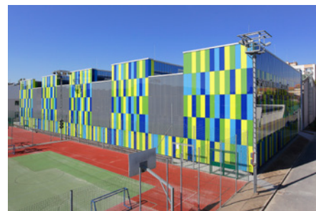
Dostavba víceúčelové sportovní haly v areálu městské sportovní haly na Slovanech, Pízeň
