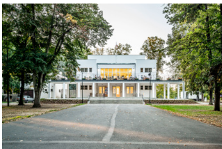
Rekonstrukce pavilonu A, Louny
