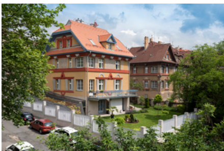
Rekonstrukce a přístavba rondokubistické vily, Praha
