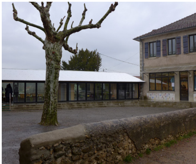
BAST, Přístavba školní jídelny v Monthbrun-Bocage. Foto BASK
