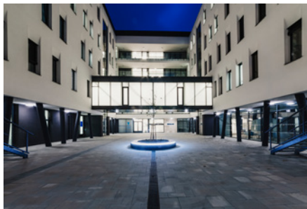
Novostavba II. interní kliniky a geriatricie, Olomouc
