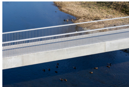
Lávka přes řeku Lubinu, Příbor
