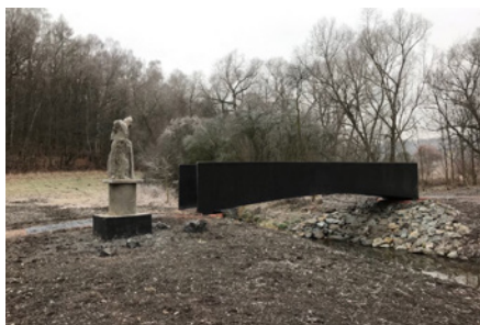
Lávka přes Dřetovický potok, Kladno Vrapice
