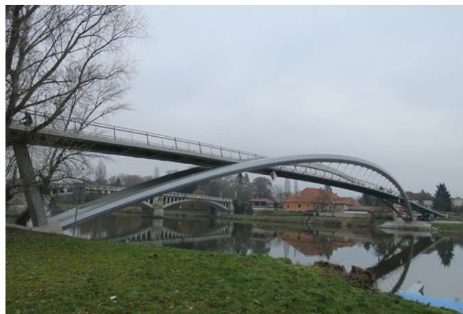
Obr. 6: Lávka přes Labe v Nymburce, 2021, architektonicko-konstrukční soutěž 2018, autoři: Jiří Stráský, Leonard Šopík, Jan Pozdíšek, Karel Zlatuška / Stráský, Hustý a partneři (SHP) Brno, foto Jan L. Vítek
