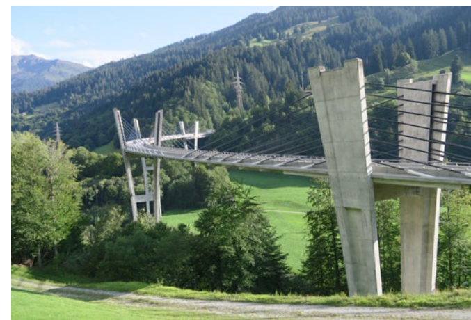
Obr. 5: Most Sunniberg z roku 1998 v údolí řeky Landquart ve Švýcarsku, délka mostu 526 m, příklad velkého integrovaného mostu, autoři: Christian Menn a Dialma Jakob Baenziger, foto Jan L. Vítka
