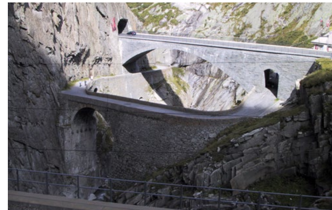
Obr. 4: Nejužší místo mezi Airolo a Göschenen na silnici v Gotthardském průsmyku ve Švýcarsku spojuje tzv. Ďáblův most (Teufelsbrücke). Původní dřevěný most byl v roce 1595 nahrazen prvním kamenným mostem, který se nakonec v roce 1888 zřítíl. Mezitím byl v roce 1830 dokončen druhý most a vedle něj pak v roce 1958 třetí most, foto Jan L. Vítka
