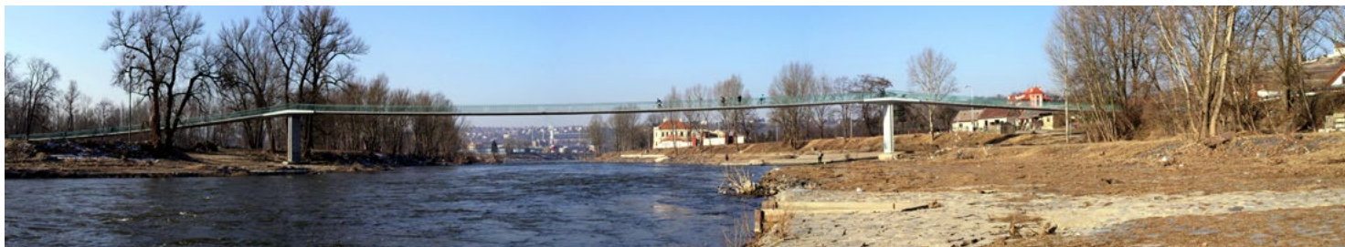
Původní Trojská lávka z roku 1984 (délka 256 m, šířka 3,8 m, soustava 156 ocelových lan se zavěšenými železobetonovými díly). Foto SimcaCZE, wikipedia.org
