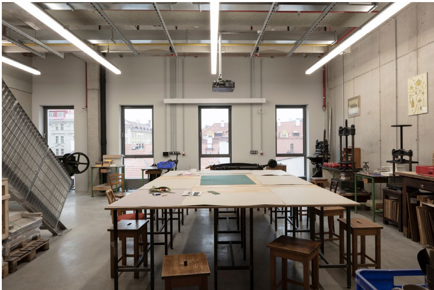
Svítlidla Perluce značky Zumtobel jsou odolná vůči prachu, a proto jsou vhodným zdrojem osvětlení v dílnách Technologického centra UMRUM. Fotografie Peter Fabo
