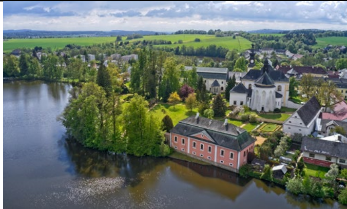
Pohled na Žďár nad Sázavou. Foto archiv města
