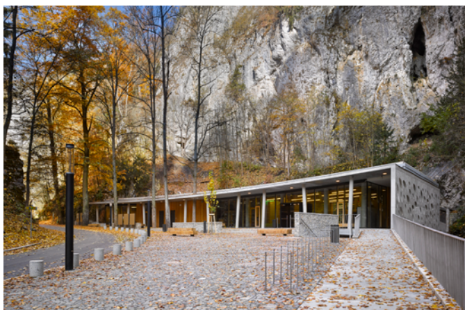
Vstupní budova areálu Punkevních jeskyní v Moravském krasu, autoři: Architektonická kancelář Burian - Křivinka / Aleš Burian, Gustav Křivinka, spolupráce Lukáš Loudíl - statika, Eva Wágnerová - sadové úpravy, Daria Křivinková - interiér; soutěž 2004, realizace 2015. Foto: Filip Šlapal
