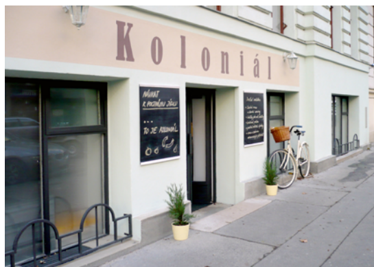
Využití ploch pod kordonovou římsou ke střešnímu označení provozovny přímo na fasádu, které je v souladu s charakterem objektu. Brno, Údolní.
