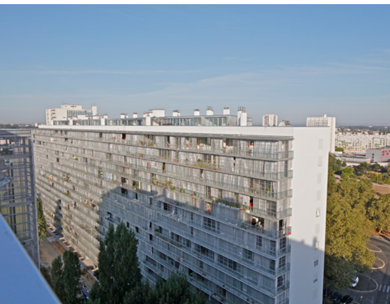
Anne Lacaton, Jean Philippe Vassal, Frederic Druot, Christophe Hutin – Regenerace panelového domu s 530 byty v Bordeaux je založena na předsazení nové fasády se zimmími zahradami, 2018. Finalista Mies van der Rohe Award 2019. Foto Philippe Ruault
