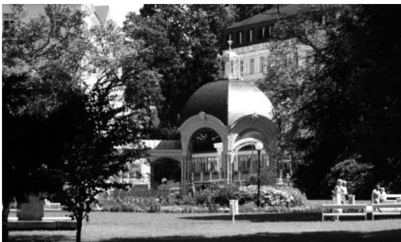
Dvořákovy sady 16. 8. 2003, budoucí staveniště Blanenského pavilonu.
