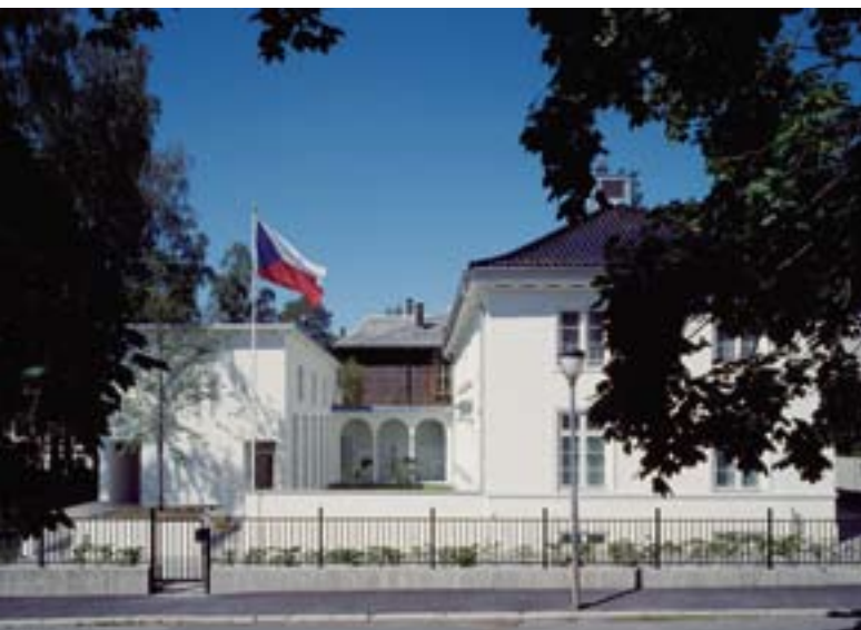
Česká ambasáda v Oslu, rekonstrukce a dostavba, 1996
