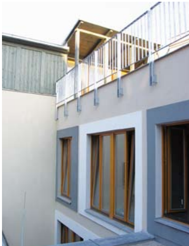
2. cena v kategorii Rekonstrukce bytového domu nebo jiné budovy pro účel bydlení Rekonstrukce historického objektu Míšeňská 4 – Hana Seho, Petr Hlaváček, R.U.A.
