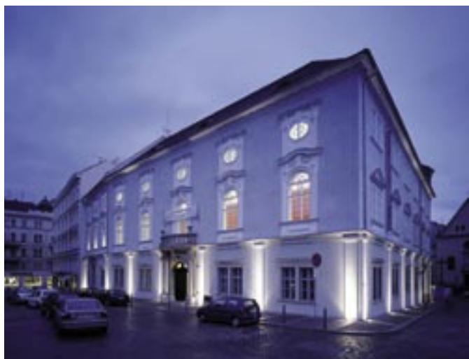
Rekonstrukce divadla Reduta v Brně – Petr Valenta, Antonín Novák, Eduard Štěrbák, Radovan Smejkal
