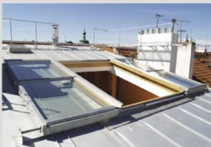
Odsuvné ateliérové prosklení SOLÁRA, Praha - kulurní ulice / provedení: masiv dub, dvojitý vysokotlaký níztlk / oplochování šn / odsv do kvě i pravě strany
