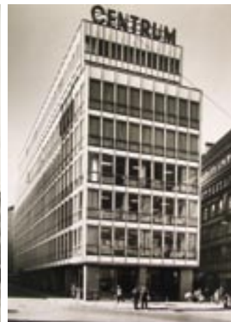
CENTRUM s novou fasádou, 70. léta
