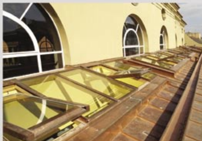
Ateliérové prosklení SOLÁRA, Praha - palác U Hybné / provedení: výběrový masiv borovice, dvojitý vysokotlaký níztlk / oplochování Cu / ošlázání elektrolýzou
