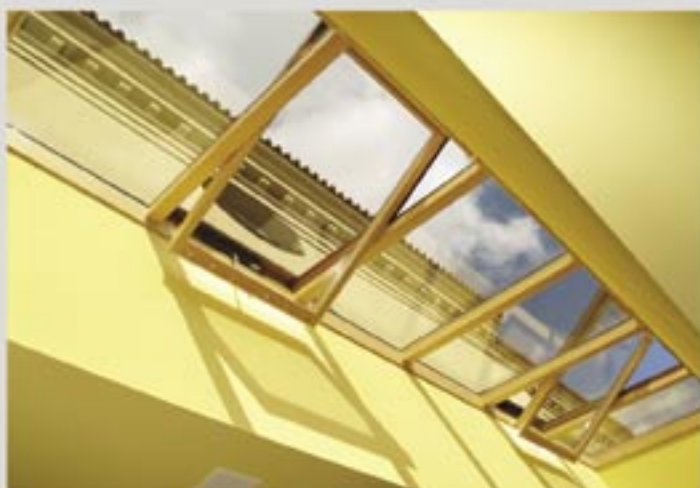
Ateliérové prosklení SOLÁRA, Praha - palác U Hybné / provedení: výběrový masiv borovice, dvojitý vysokotlaký níztlk / oplochování Cu / ošlázání elektrolýzou
