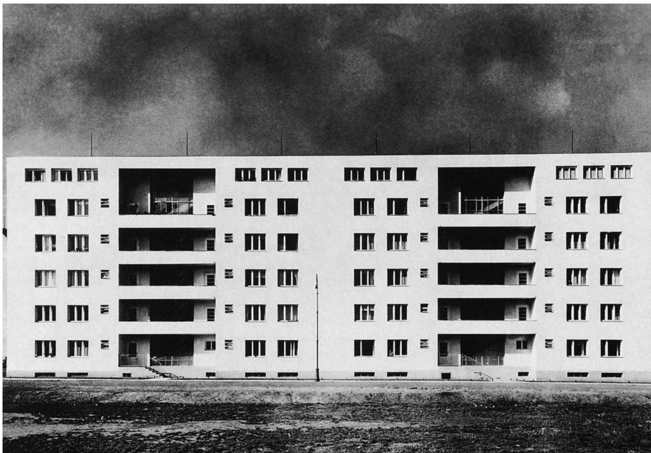
J. Polášek: Soubor nájemních domů, Vranovská ul., 1930–31, Brno
