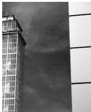
Autoři: Viktor Rudiš, Martin Rudiš, Zdenka Vydrová – realizace rekonstrukce a dostavby Pavilonu G, Brněnské veletrhy a výstavy (1995–96)
