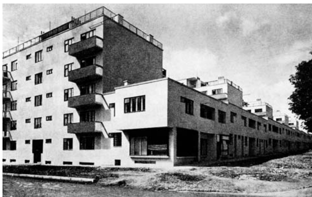
J. Polášek: Soubor nájemních domů, Vodova ul. a Skácelova ul., 1931–32, Brno
