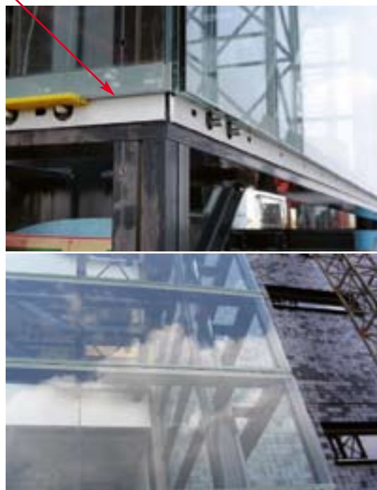
Detail použití 3M VHB strukturální pásky k lepení fasádního zasklení na kovovou konstrukci budovy
