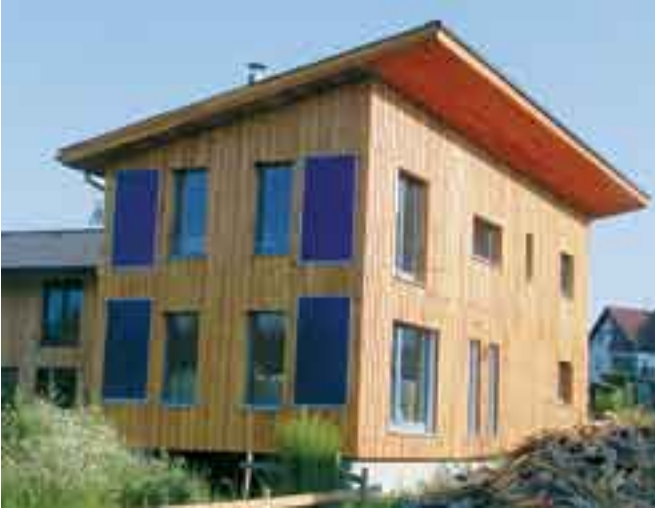
Bytový dům, Čerčany, 50 bytů Čím větší je stavba, tím příznivější je poměr obálky proti objemu a je možno lépe dosáhnout nízkooenergetických a pasivních standardů; OSB desky mohou být v rámci difuzně otevřené skladny použity namísto parozábrany.
