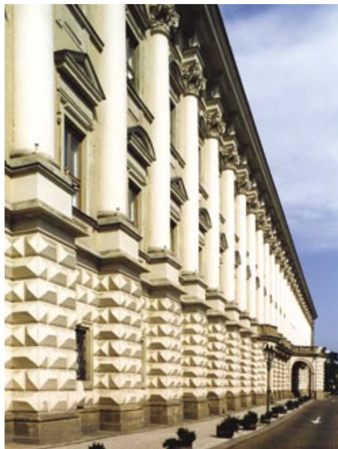
Černínský palác, Praha-Hradčany, rekonstrukce fasád, 1996, autor: Alexander Gjuric
