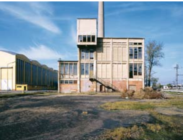
Zdeněk Plesník, Kotelna závodu MEZ v Hulíně, 1950–1954
