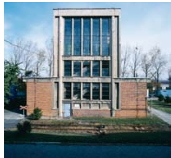
Zdeněk Plesník, Trafostanice závodu MEZ v Hulíně, 1950–1954
