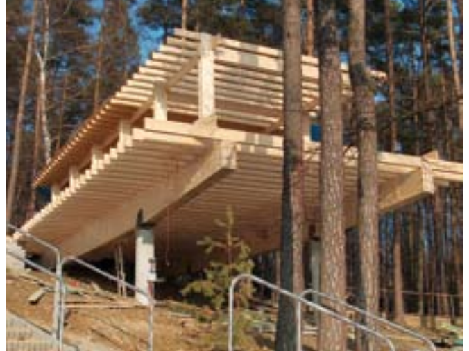
Studio bydlení, Kopřivnice, 2002–2003 – konstrukce se sbíjených vazníků s plechovými styčníky, tepelná izolace foukaný papír climatizer plus, borovicový obklad na fasádě, karton a OSB desky v interiéru.
