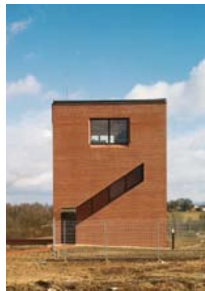
Meteorologická stanice, Cheb, 1997–2001, realizace; spolupráce: Tomáš Koumar, Jan Hájek; foto: Filip Šlapal
