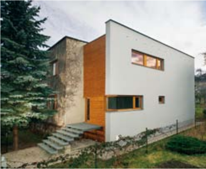
Přístavba, stavební úpravy rodinného domu, Kopřivnice, 2004 – RD Holub , stávající dům obrostlý zeleným břečtanem, přístavba s požární zdi (požárně nebezpečný prostor dřevěného obkladu přístavby nezasaahuje na blízký pozemek souseda), původní záměr dřevěného kontejneru jako lehké přístavby nebyl realizován z důvodu požární ochrany, foto studio Toast.
