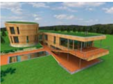
Pasivní dřevěný rodinný dům, Brdy, 2004 (tepelné ztráty – 9,5 kW, zastavěná plocha 354 m 2 , užitná plocha 460 m 2 , obestavěný prostor 2150 m 3 ); pasivní rodinný dům má podle evropských standardů sníženou spotřebu tepla pro vytápění pod 15 kWh/m 2 /rok – oproti současné běžné výstavbě v ČR 100 až 250 kWh/m 2 /rok).
