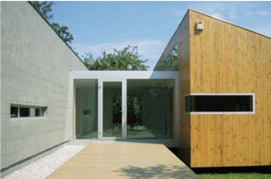
Rodinný dům, Kopřivnice, 2006 – RD Buzga , dřevostavba s fošinkovou konstrukcí, lepený dřevěný vazník nad prosklenou částí obývacího prostoru, provětrávané fasádní cetrisové desky, nízkoenergetický dům s rekuperací, foto realizace studio Toast.
