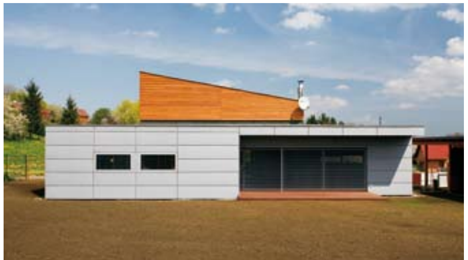
Rodinný dům, Kopřivnice, 2006 – RD Buzga , dřevostavba s fošinkovou konstrukcí, lepený dřevěný vazník nad prosklenou částí obývacího prostoru, provětrávané fasádní cetrisové desky, nízkoenergetický dům s rekuperací, foto realizace studio Toast.
